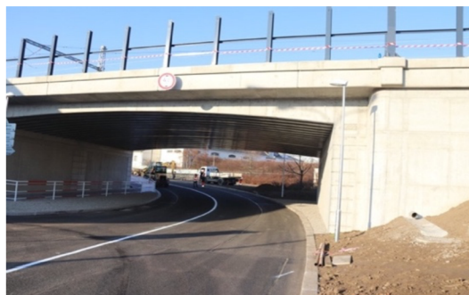
Obr. č.4: Most po rekonstrukci
