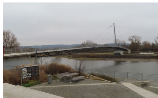
Obr. č.10: Lávka po rekonstrukci
