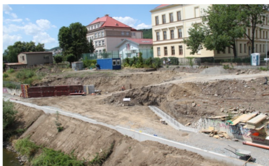
Obr. č.11: Místo u řeky před rekonstrukcí
