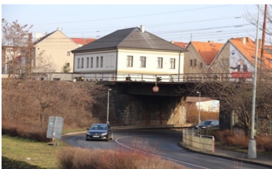
Obr. č.3: Most před rekonstrukcí
