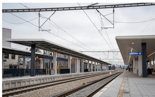
Obr. č.14: Nádraží po rekonstrukci
