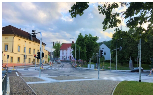
Obr.č.6: Křižovatka po rekonstrukci
