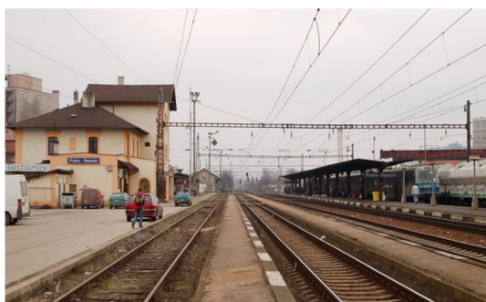
Obr. č.13: Nádraží před rekonstrukcí
