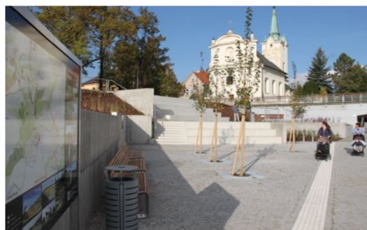
Obr. č.12: Místo u řeky po rekonstrukci
