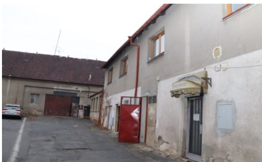
Obr. č.7: Kul. centrum před rekonstrukcí
