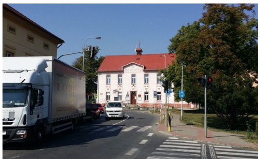
Obr.č.5: Křižovatka před rekonstrukcí
