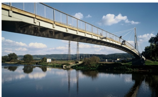
Obr.č.9: Lávka před rekonstrukcí
