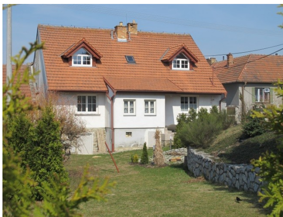
Obr. 12.4.2.5 Fotodokumentace stavu parcely st. 81 v terénu
