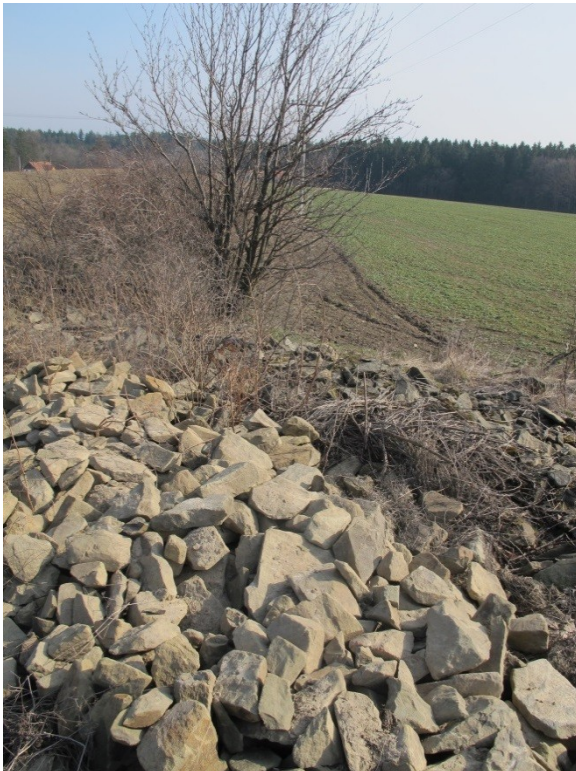
Obr. 5.2.1 Fotodokumentace o zničení podrobného bodu polohového pole 518
