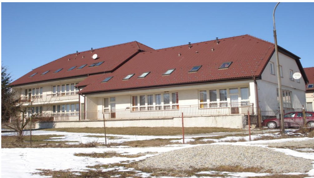
Budova mateřské školky (původní problém s rovnou střechou, kdy hrozilo zatékání do budovy byl vyřešen výstavbou nových bytů)
