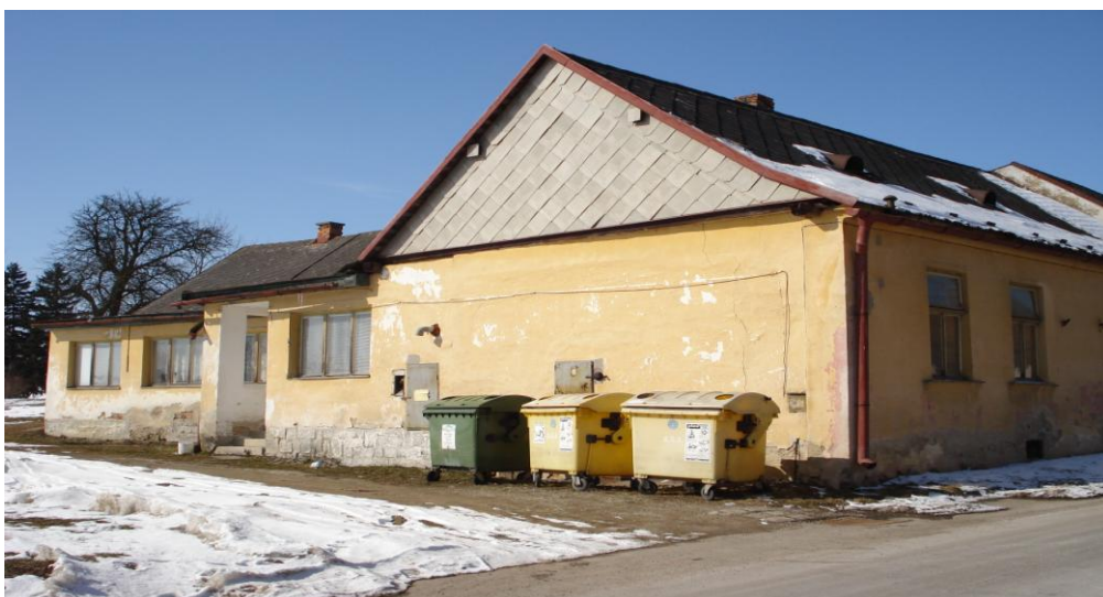
Plánovaná demolice budovy odkoupené od církve a plánovaná výstavba hasičské zbrojnice
