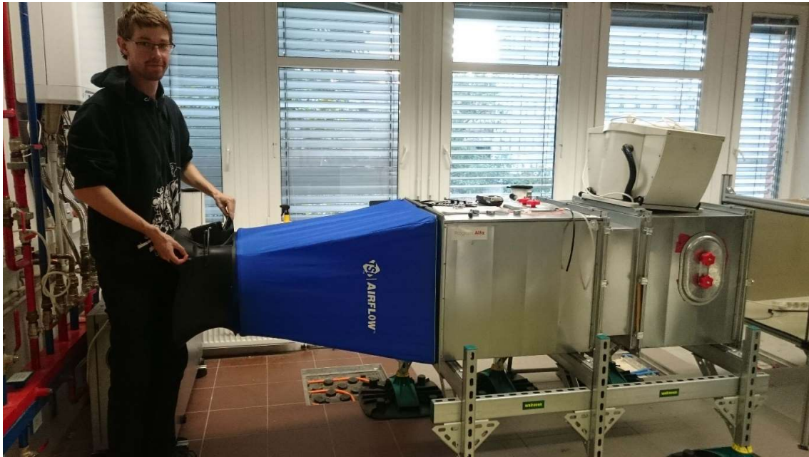
Obrázek 30 - Měření průtoku vzduchu Balometrem
