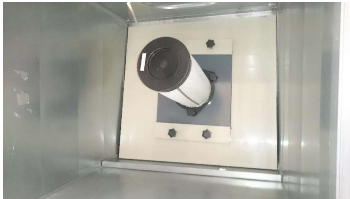
Obrázek 19 - Upevnění kartušového filtru
