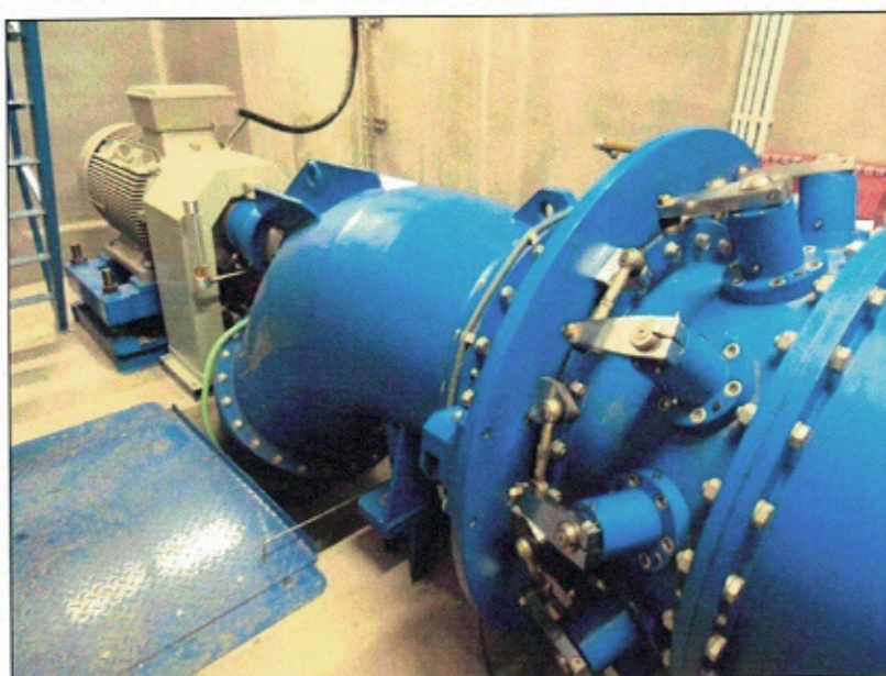
Obrázek 2: Turbosoustrojí nové MVE III (turbína a generátor)
