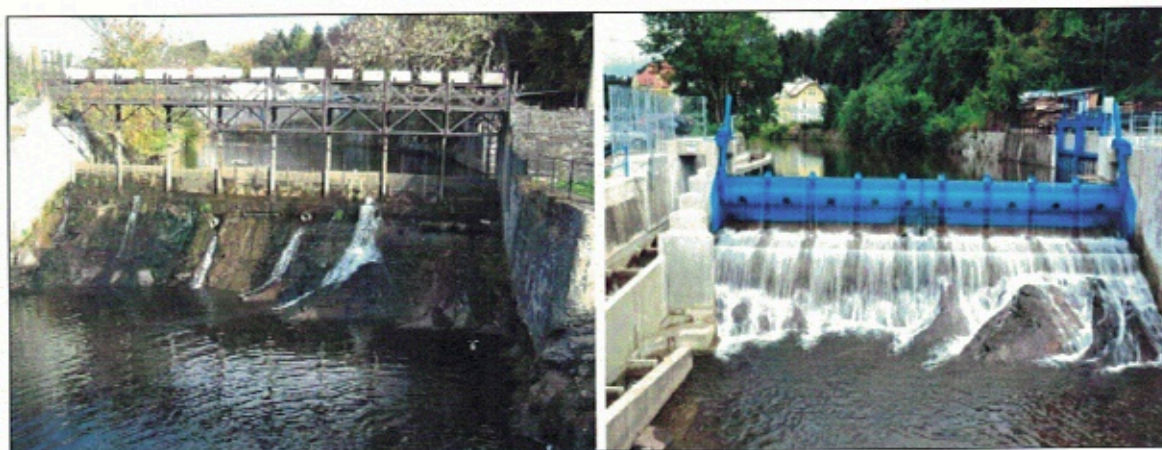
Obrázek 4: Původní jez a nový jez s rybím přechodem
