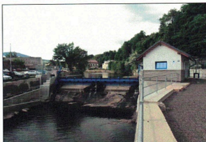
Obrázek 3: Nový jez s rybím přechodem a budovou MVE III
