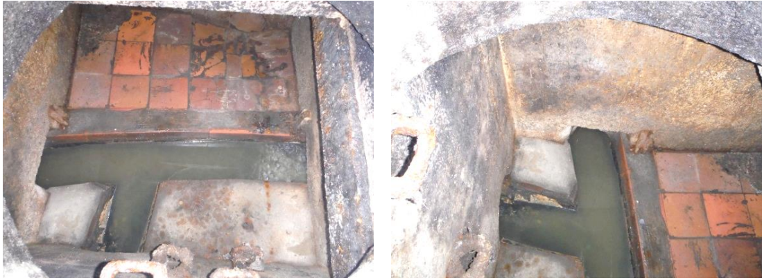
Obrázky 70, 71: Odlehčovací komora č. 16, Plzeňská ul., u trafostanice, přepadová hrana betonová s obkladem.
