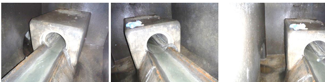
Obrázky 53, 54, 55: Odlehčovací komora č. 7, Mattoniho nábřeží, u čp. 53, s přepadem oboustranným bočním se šikmými hranami.
