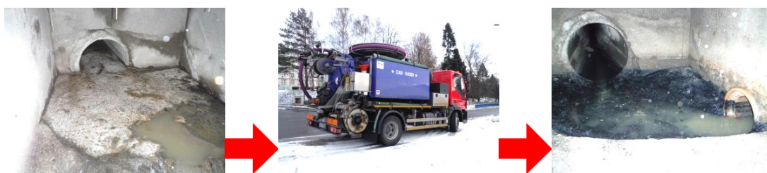
Obrázky 14, 15, 16: OK č. 3, Táborská ul., lidová škola umění; stav před vyčištěním; kombinovaný hydromechanizační vůz; stav po vyčištění.
