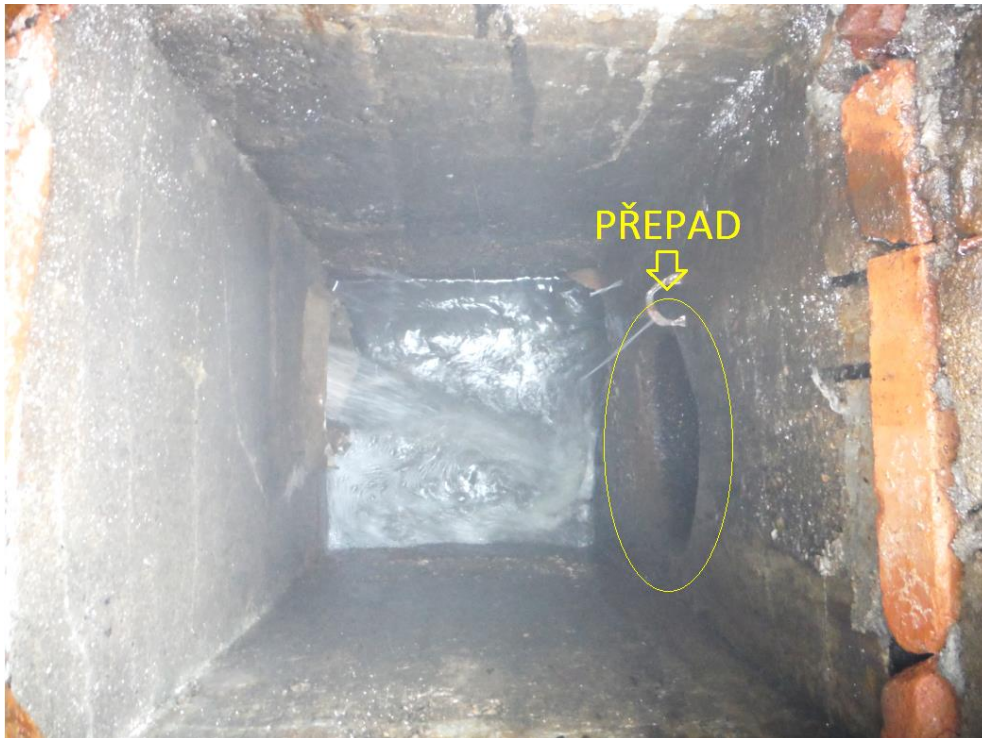
Obrázek 64: Odlehčovací komora č. 29, Moravská/Hynaisova ul., Petřín, přepadová hrana – trouba.
