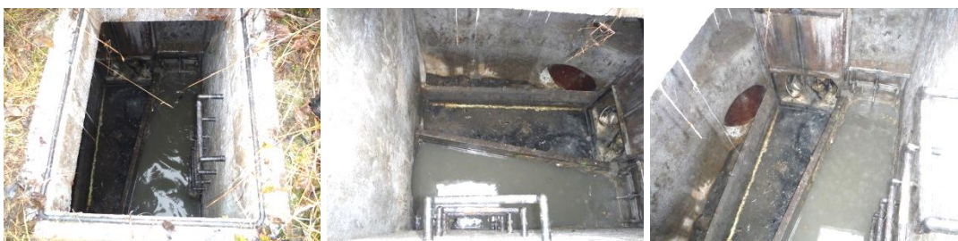
Obrázky 35, 36, 37: Odlehčovací komora č. 38, Čankovská ul., shybka u koupaliště, s přepadem jednostranným bočním se šikmou hranou.
