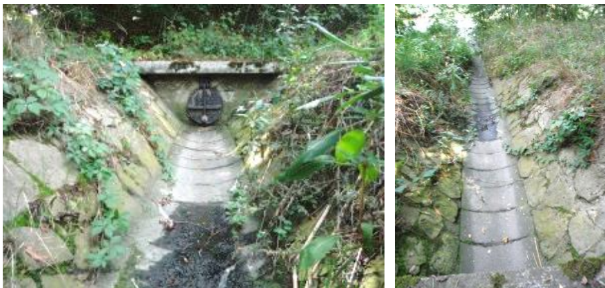
Obrázky 23, 24: Výustní objekt a koryto odlehčení OK č. 7, Mattoniho nábřeží, u čp. 53, fotografie implementované do GISu Marushka.
