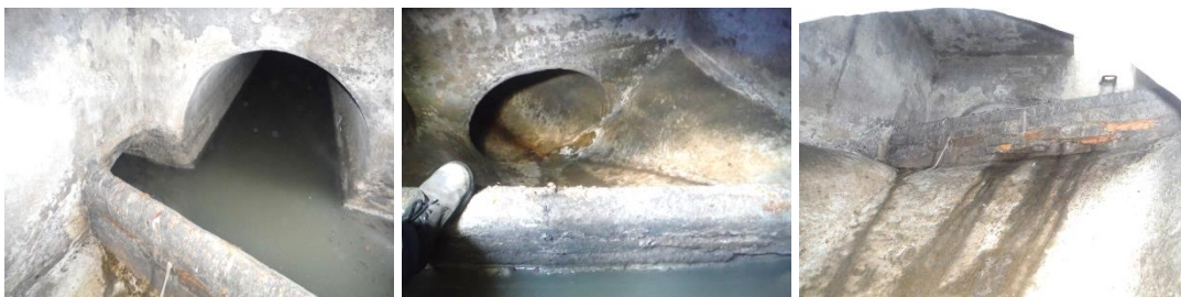
Obrázky 58, 59, 60: Odlehčovací komora č. 2, Táborská ul., lapač písku, přeřadová hrana vyzdění z cihel.
