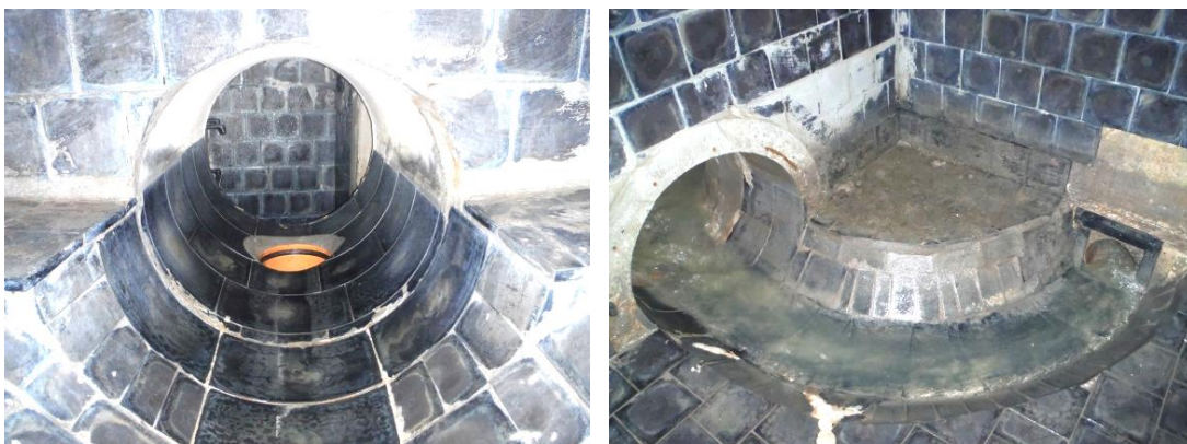
Obrázky 81, 82: Odlehčení OK č. 15, Sokolovská/Nejdecká ul., U Konička – pohled do odlehčení, spadišťové šachty; přítok DN 800 a odtok DN 250 – škrťací trať v délce 37,6 m.
