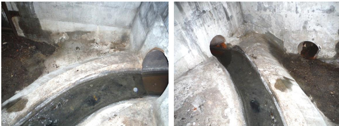
Obrázky 56, 57: Odlehčovací komora č. 43, Rolavská ul., u autoservisu, přeřadová hrana betonová.
