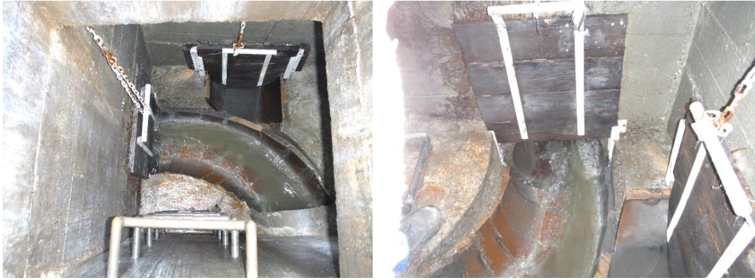
Obrázky 93, 94: OK č. 44, Mlýnská ul., propojení sběračů.
