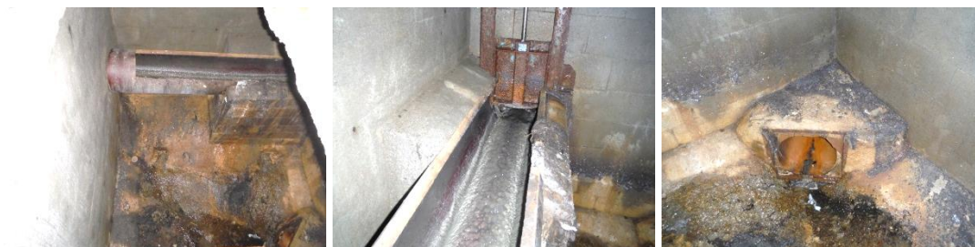
Obrázky 48, 49, 50: Odlehčovací komora č. 52, Háje, u mostu, s přepadem oboustranným bočním s přímými hranami.
