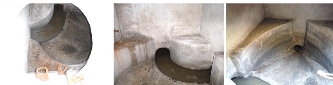
Obrázky 29, 30, 31: Odlehčovací komora č. 47, ul. Kpt. Jaroše, most u školy, s přepadem přímým v oblouku.
