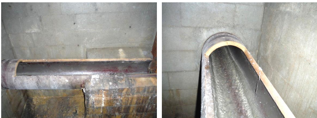
Obrázky 68, 69: Odlehčovací komory č. 52, Háje, u mostu, přepadová hrana kameninová – tvořena kameninovou troubou.
