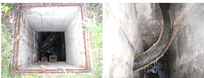
Obrázky 51, 52: Odlehčovací komora č. 39, Mlýnská ul./Dlouhá ul., v zahrádkách, s přepadem oboustranným zavěšeným v oblouku.
