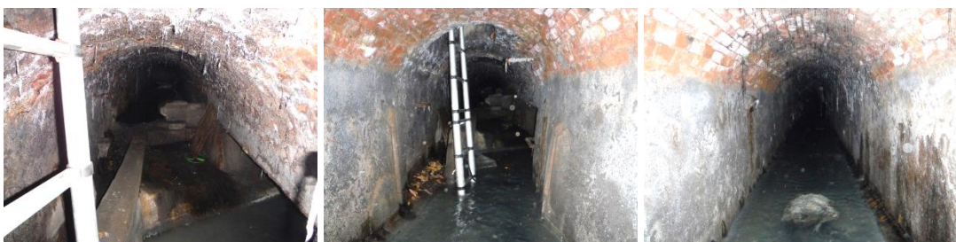
Obrázky 45, 46, 47: Odlehčovací komora č. 25, Dvořákovy sady, LD Thermal, před shybkou, s vertikální dělicí stěnou, jednostranné přímé se šikmou hranou.
