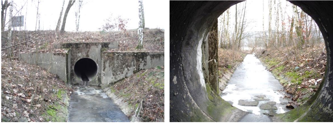
Obrázky 84, 85: Výustní objekt odlehčovací stoky OK č. 13, Dolní Kamenná, u McDonalda.
