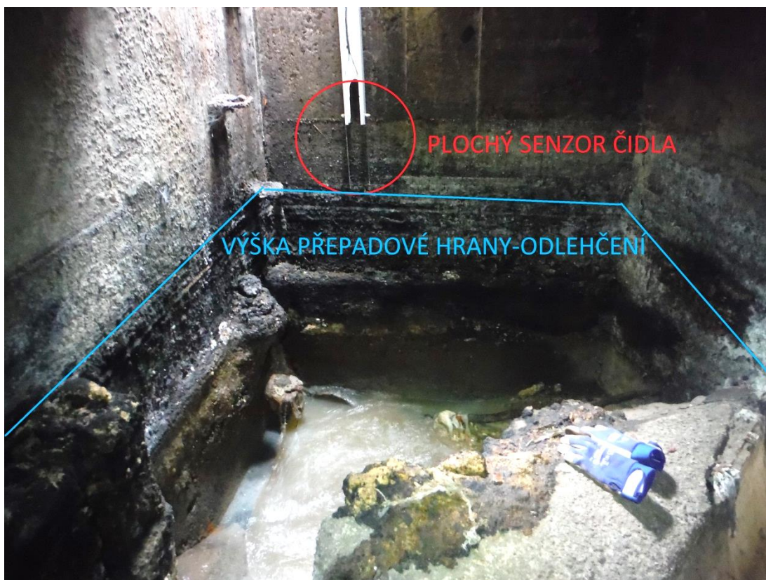
Obrázek 90: OK č. 30, Divadelní náměstí, u stánku, čidlo zatopení pro přenos dat na dispečink, orientační hladina přepadu.
