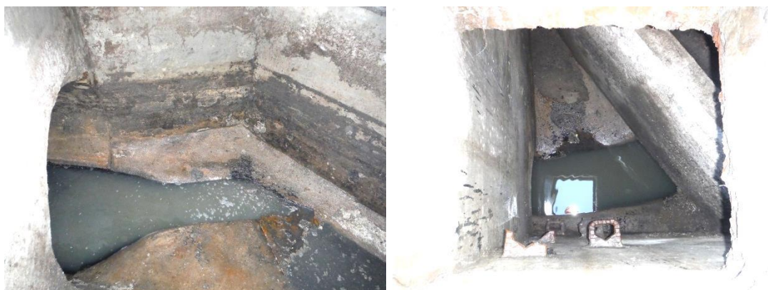
Obrázek 91, 92: OK č. 42, Nádražní ul., most ČD - s přepadem jednostranným bočním se šikmou hranou.
