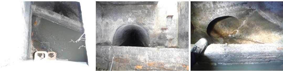
Obrázky 41, 42, 43: Odlehčovací komora č. 02, Táborská ul., lapač písku, s přepadem přímým šikmým.
