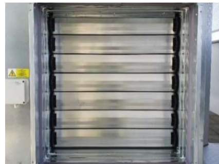
Obr. 27 Vstupní a výstupní klapky
