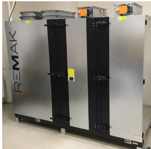
Obr. 5 VZT zařízení se sáním/výtlačem na vrchním plášti
