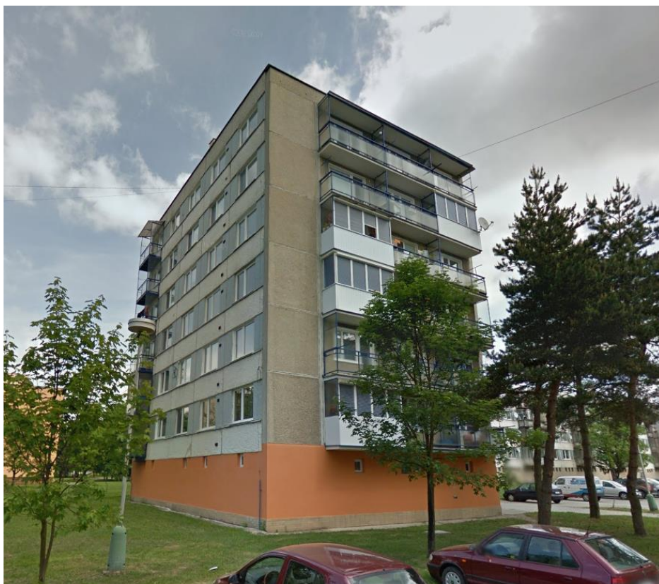
Obr. č. 14 – Referenčný panelový bytový dom (autor)
