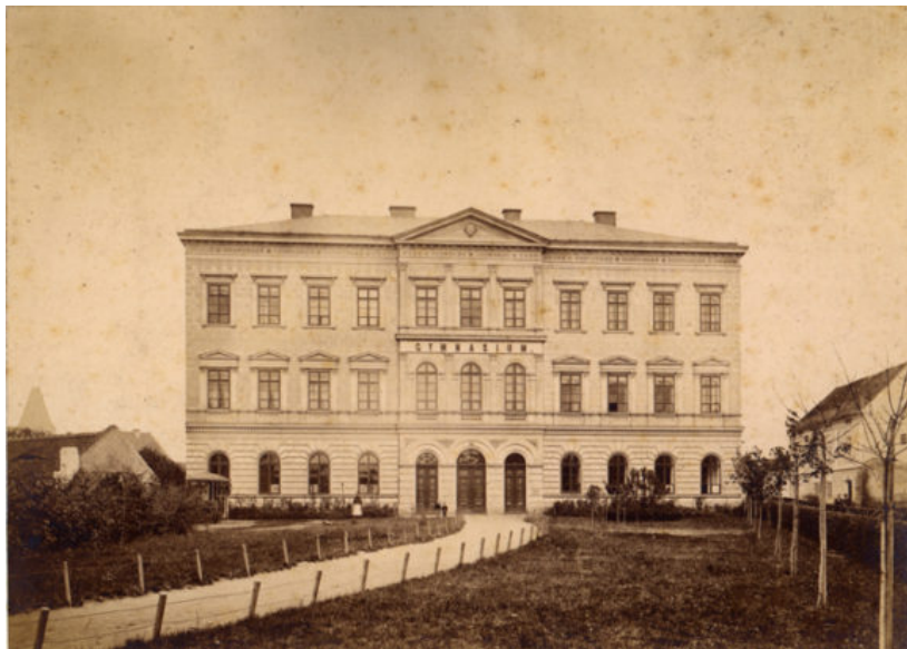
Obrázek 1. Hlavní budova SPŠS a OA Kadaň
