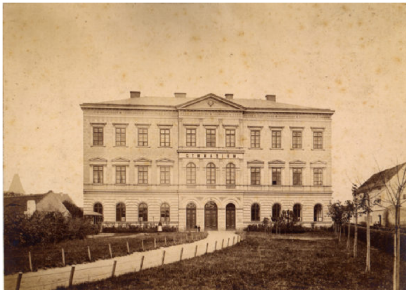
Obrázek 1. Hlavní budova SPŠS a OA Kadaň
