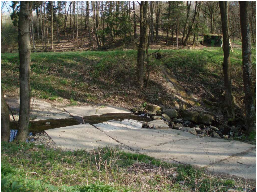
Obr. č. 6 Antropogenně vytvořený brod mezi rybníky (foto P. Bor 24.4. 2010)
