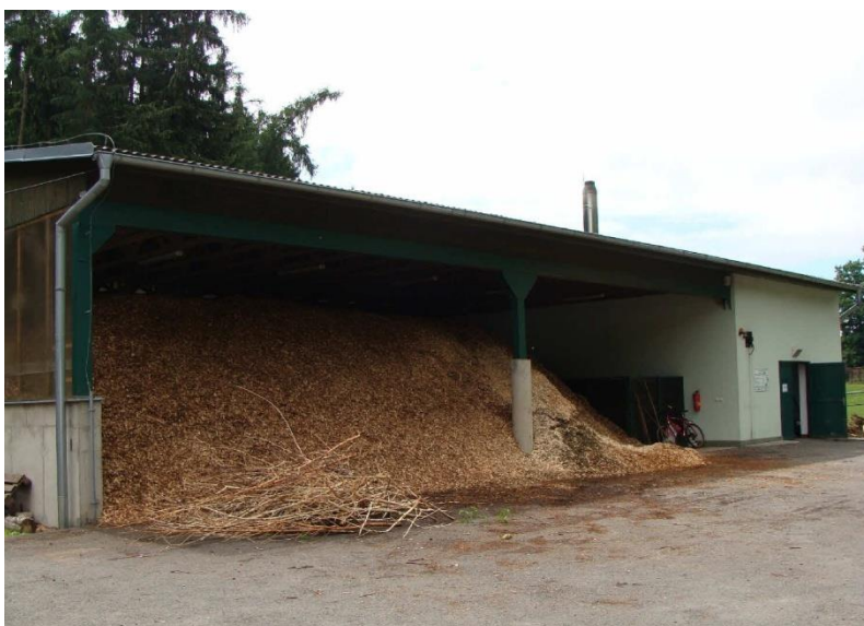
Obr. 4 Sklad –t pky a pohled na Centrální výtopnu
