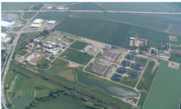
Obrázek č. 4 - ČOV Modřice- celkový pohled
