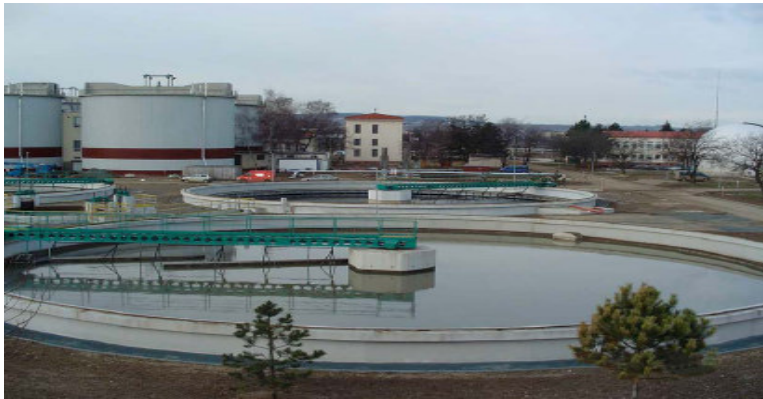
Obrázek č. 5 – Usazovací nádrže
