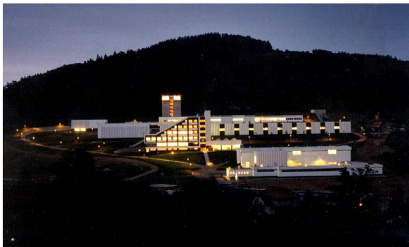
Obrázek č. 3 - ÚV Švařec- noční pohled pro úpravnu Švařec
