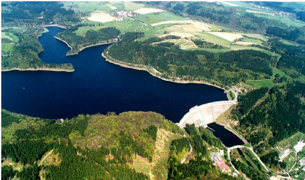
Obrázek č. 2 - Přehradní nádrž Víř- zdroj surové vody
