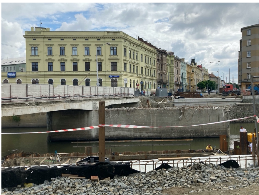
Příloha 12 - Pohled na průběh bourání poloviny mostu na Masarykově třídě, červenec 2020 (archiv autorky)
