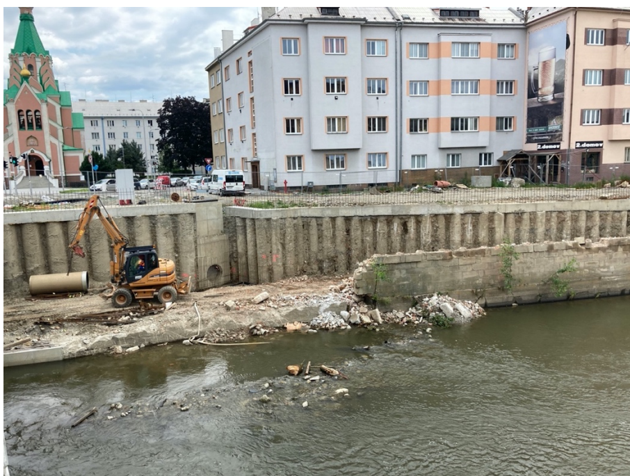
Příloha 10 - Bourání nábreží při mostě Komenského, červenec 2020 (archiv autorky)
