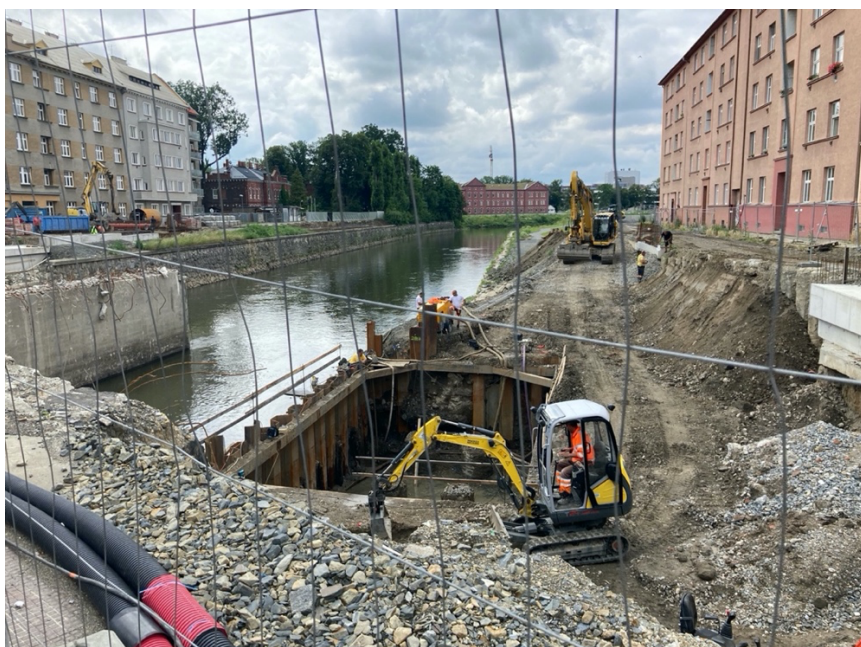
Příloha 13 - Průběh stavebních úprav, červenec 2020 (archiv autorky)
