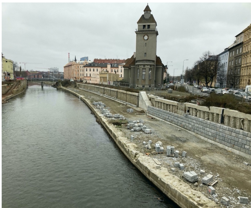
Příloha 15 - Pohled na nábřeží z mostu Komenského, prosinec 2020 (archiv autorky)
