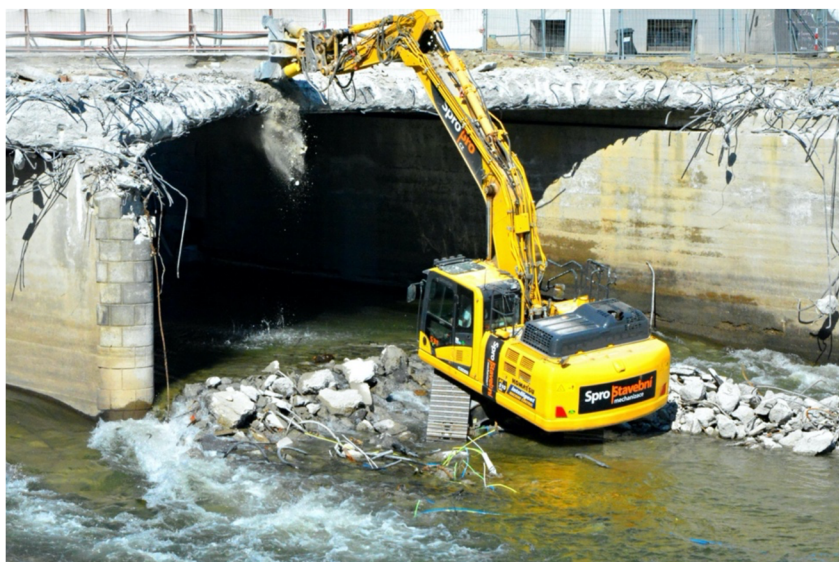
Příloha 16 - Bourání mostu na Masarykově třídě, duben 2020 (protipovodnovaopatreni.olomouc.eu)
