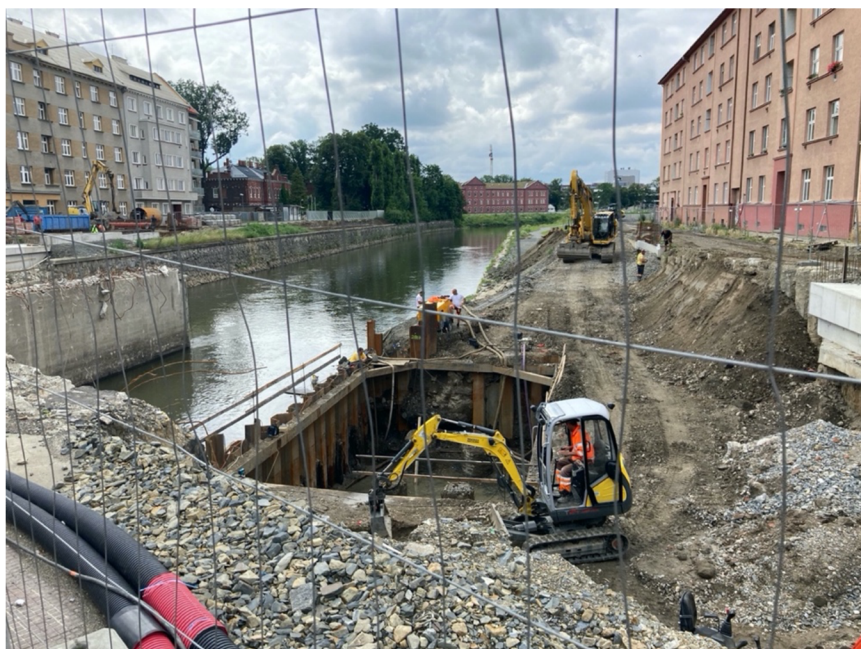
Příloha 13 - Průběh stavebních úprav, červenec 2020 (archiv autorky)
