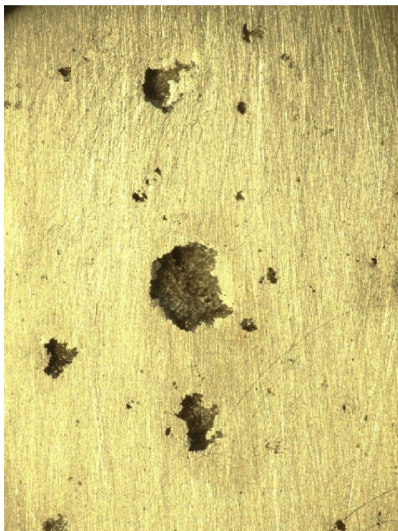
Obr. 23 Detail koroze na oceli 1.4309.
