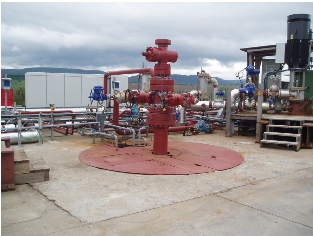
Příloha č. 14: Snímek zachycující ústí vrtu v geotermální elektrárně Soultz-sous-Forêts ve Francii
