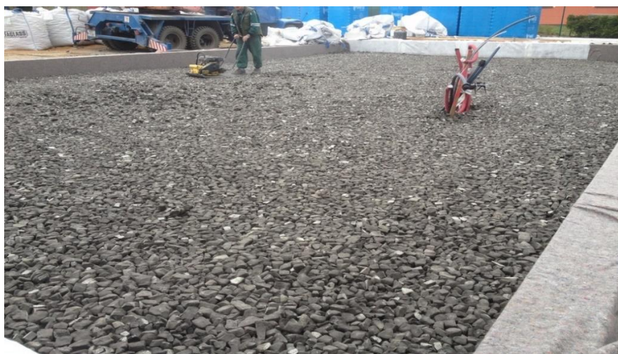
Obr. 3 Fotografie tepelně izolačního podsypu pod základovou konstrukcí rodinného domu (České stavby, ©2021)
