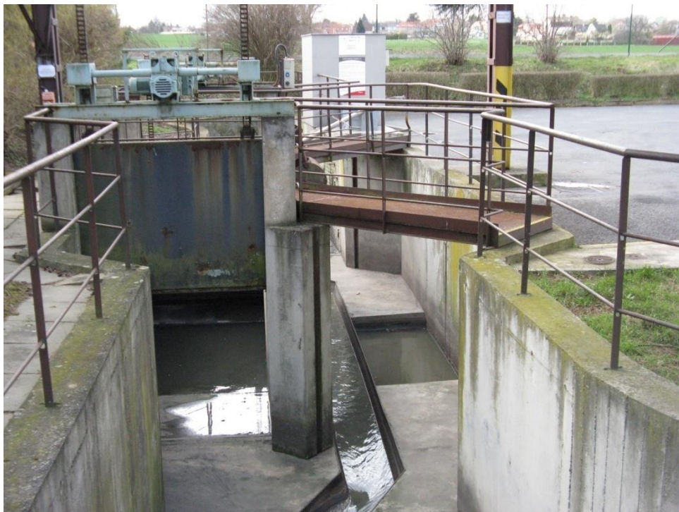
Příloha č. 2: Vypínací komora s lapáky šterku (v pozadí výpustní místo A)
