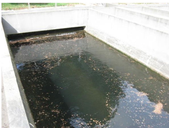
Příloha č. 16: Dočišťovací nádrž
