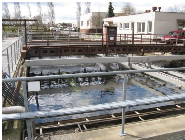
Příloha č. 14: Dosazovací nádrž
