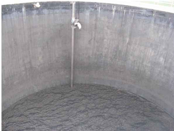
Příloha č. 18: Pohled do uskladňovací nádrže
