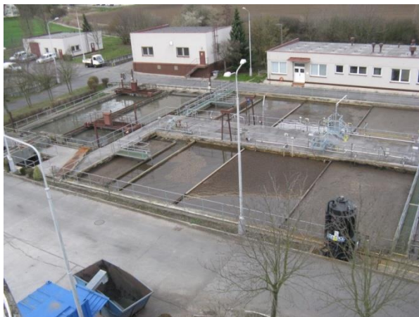
Příloha č. 21: Pohled na aktivační nádrže shora akumulční kalové nádrže
