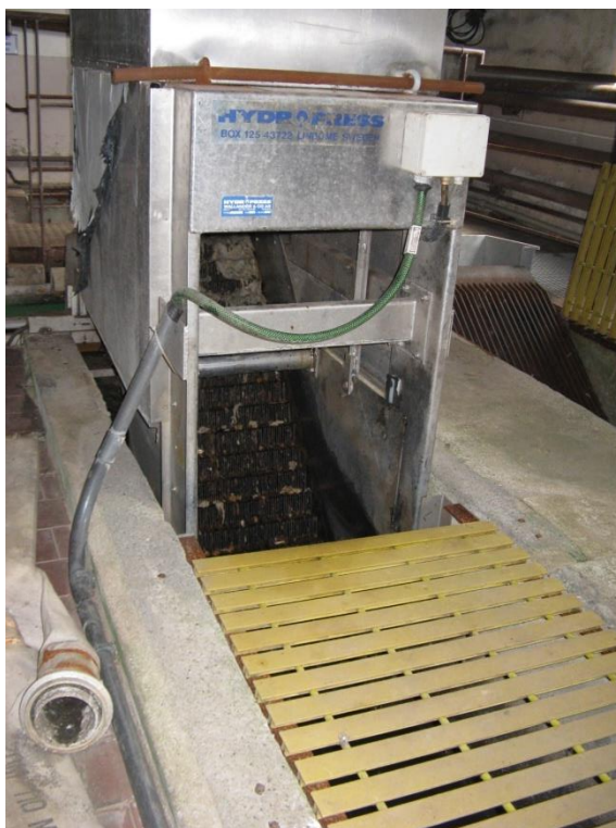
Příloha č. 6: Strojní a ručně stírané česle
