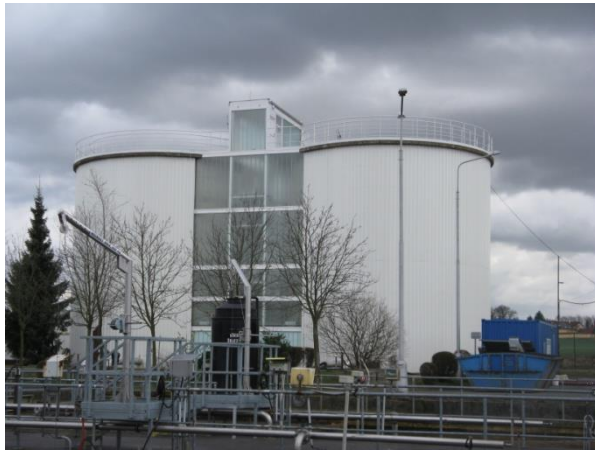
Příloha č. 17: Uskladňovací kalové nádrže
