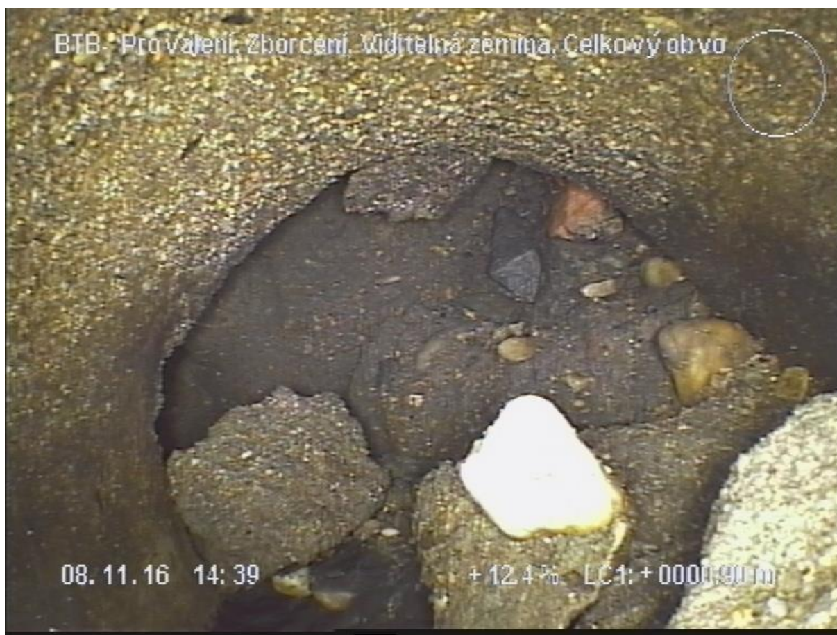
Obr. 7.10 Obrázek z kamerového průzkumu [11]
