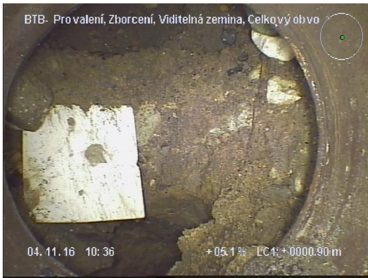
Obr. 7.17 Obrázek z kamerového průzkumu [11]
