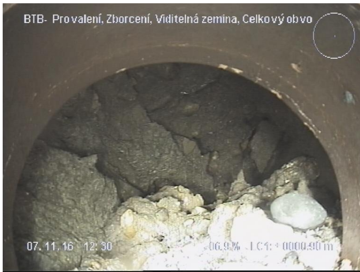
Obr. 7.26 Obrázek z kamerového průzkumu [11]
