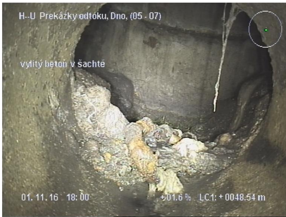
Obr. 7.15 Obrázek z kamerového průzkumu [11]
