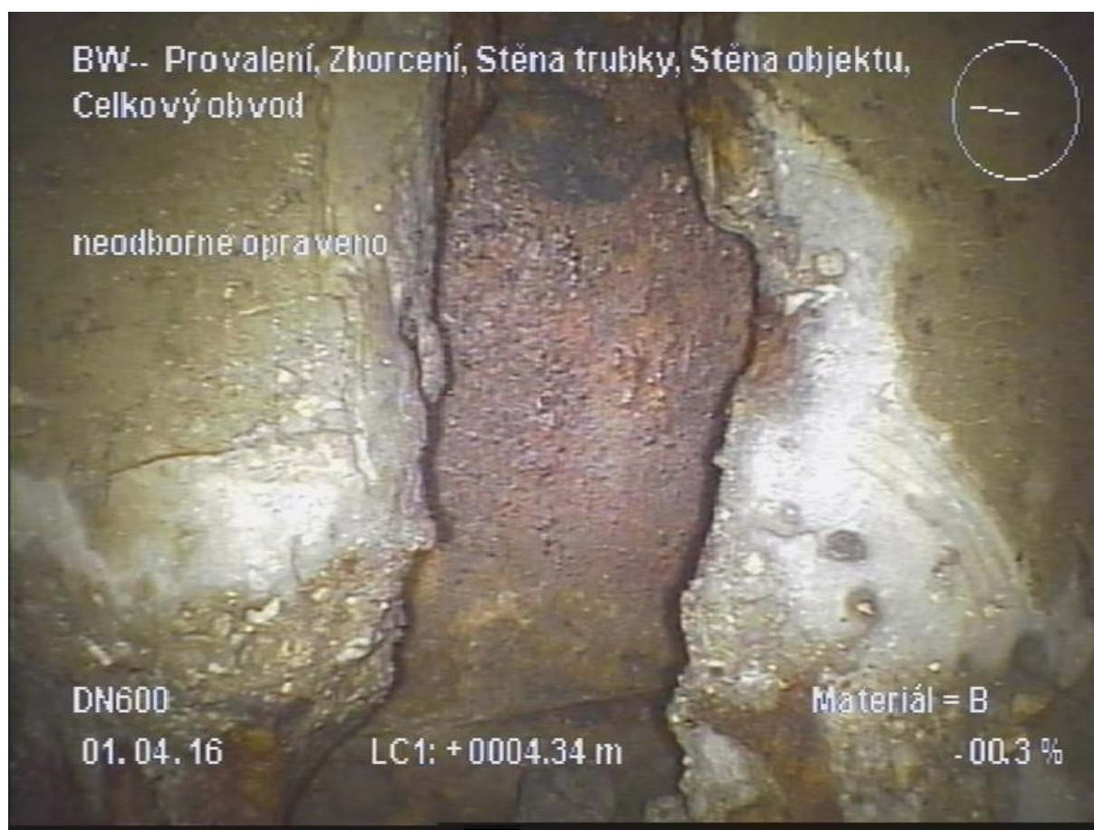
Obr. 7.6 Obrázek z kamerového průzkumu [11]
