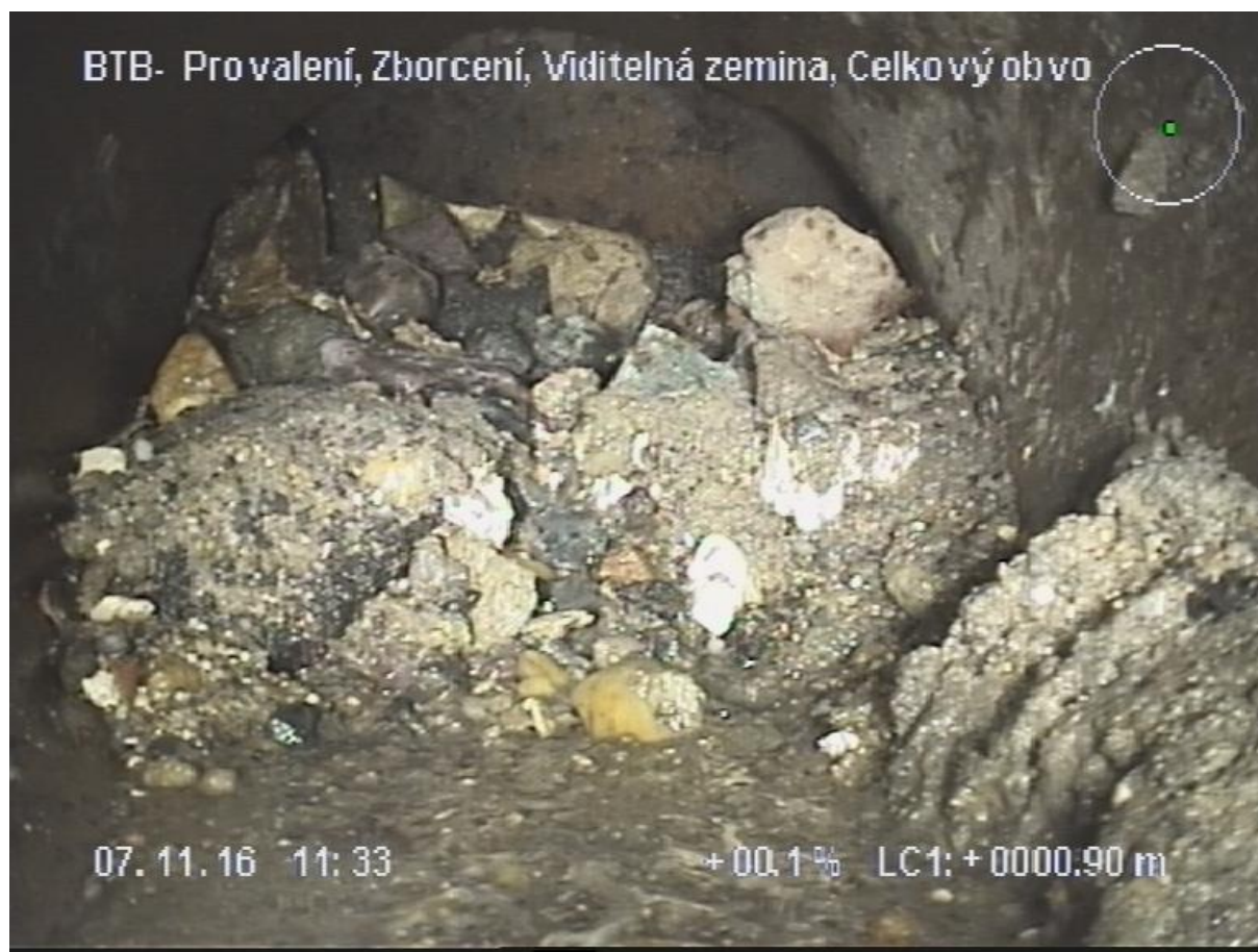
Obr. 7.21 Obrázek z kamerového průzkumu [11]
