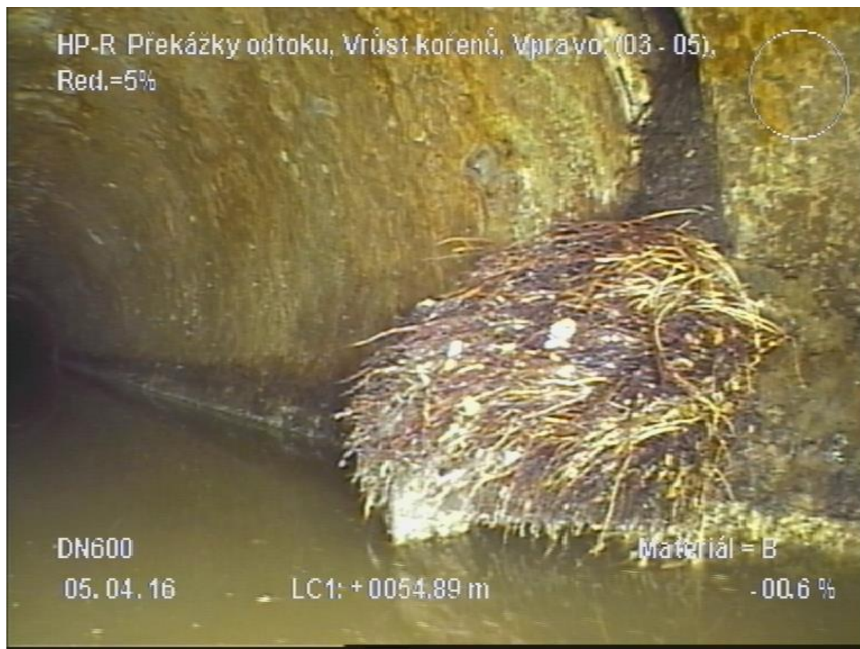
Obr. 7.1 Obrázek z kamerového průzkumu [11]
