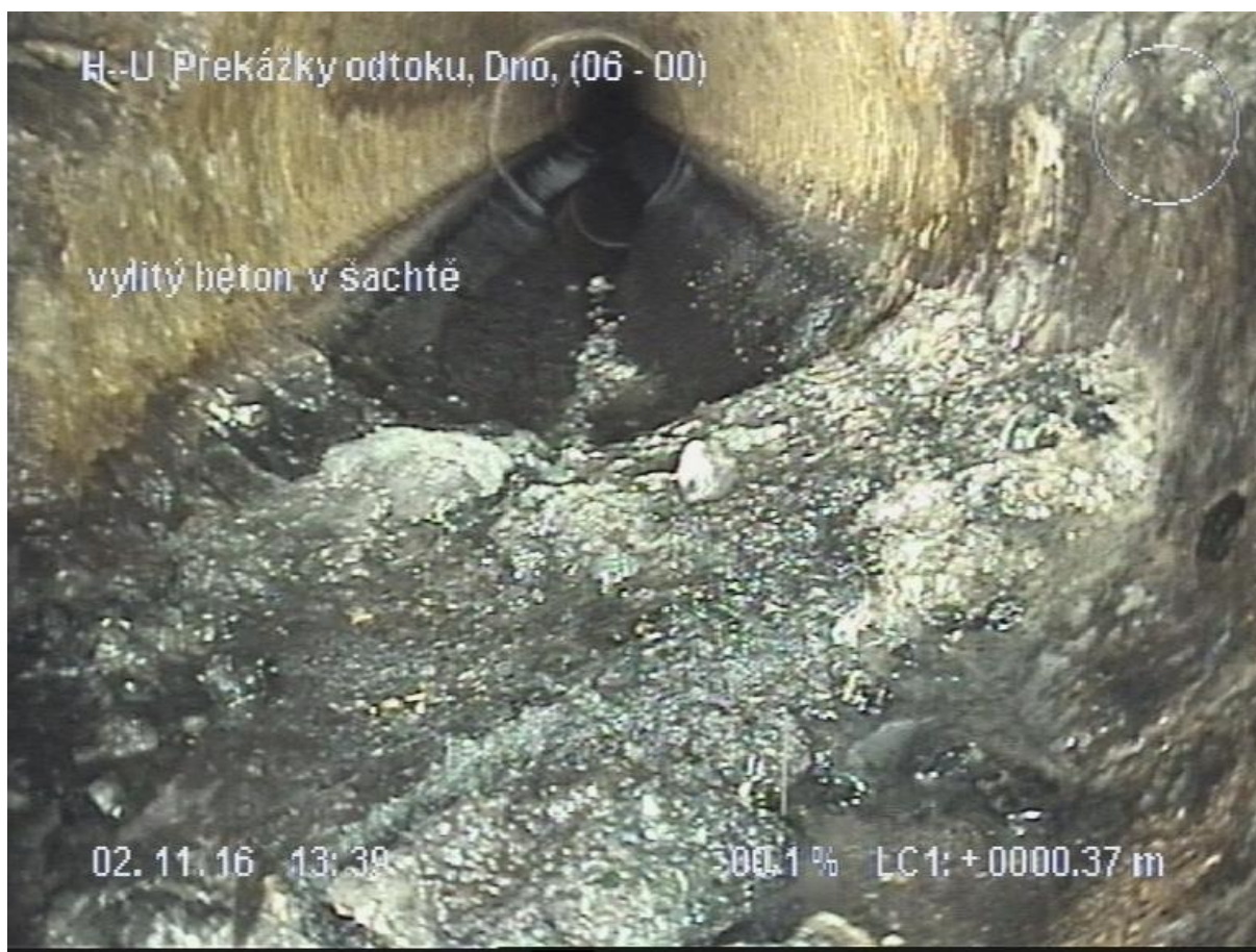
Obr. 7.24 Obrázek z kamerového průzkumu [11]
