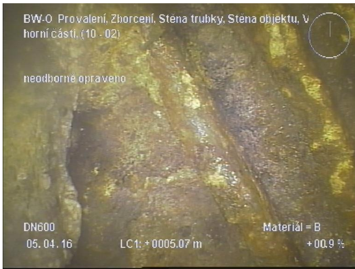
Obr. 7.3 Obrázek z kamerového průzkumu [11]
