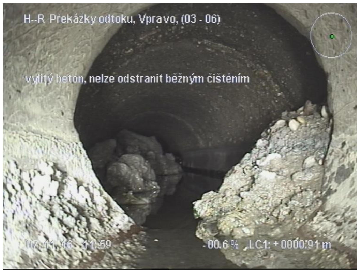
Obr. 7.23 Obrázek z kamerového průzkumu [11]
