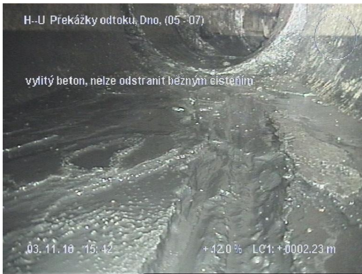
Obr. 7.31 Obrázek z kamerového průzkumu [11]
