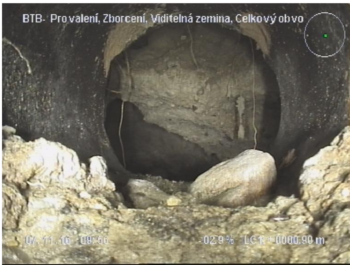
Obr. 7.11 Obrázek z kamerového průzkumu [11]
