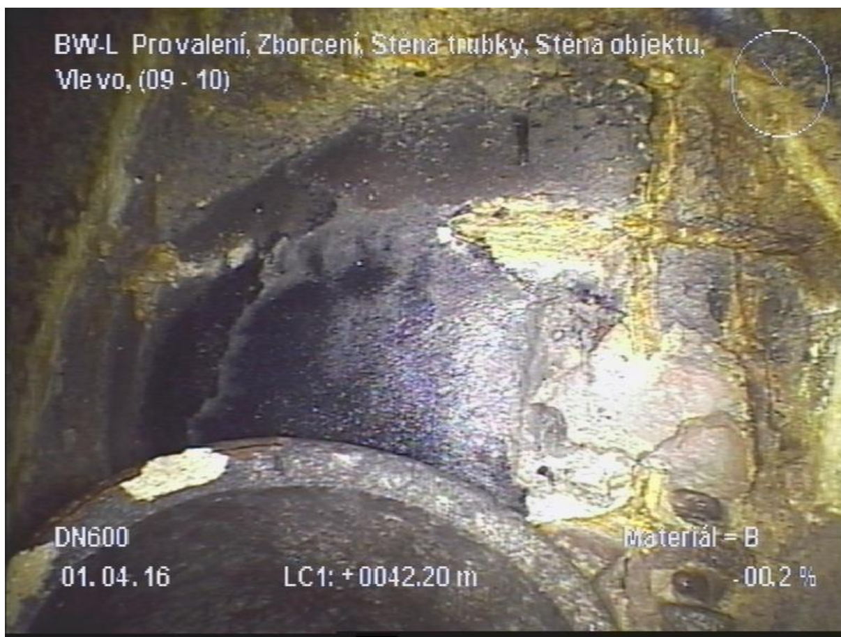
Obr. 7.9 Obrázek z kamerového průzkumu [11]
