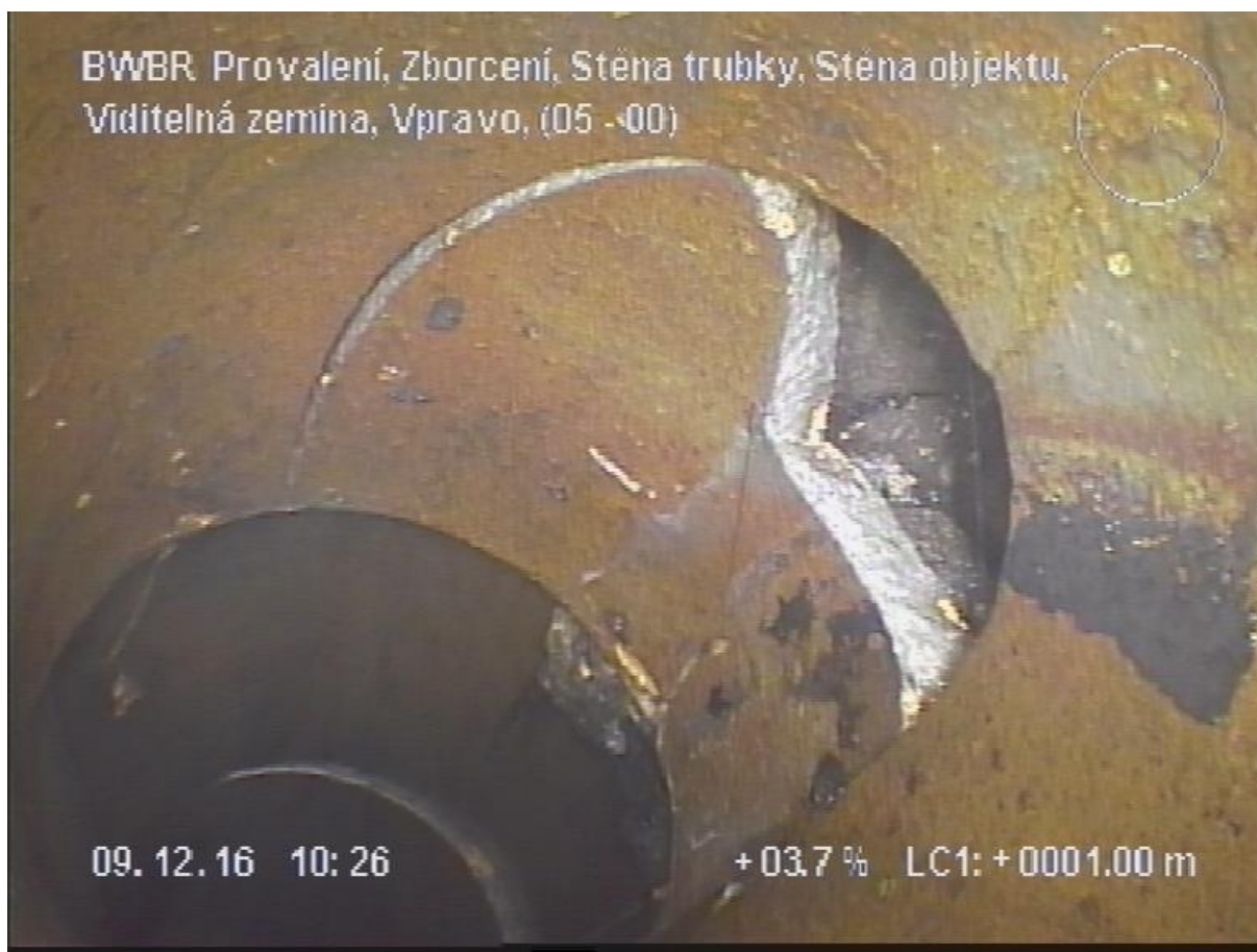
Obr. 7.30 Obrázek z kamerového průzkumu [11]
