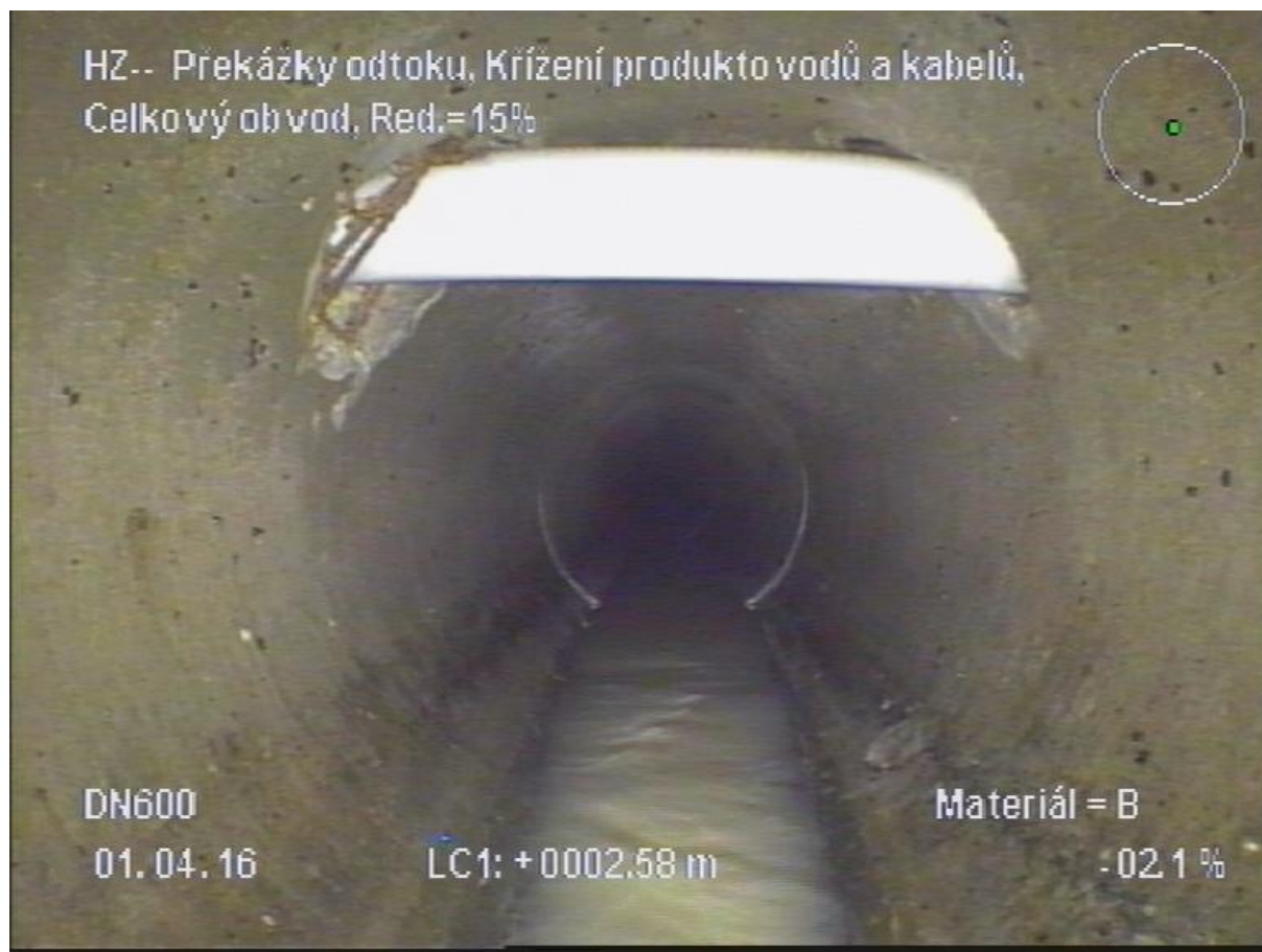
Obr. 7.8 Obrázek z kamerového průzkumu [11]
