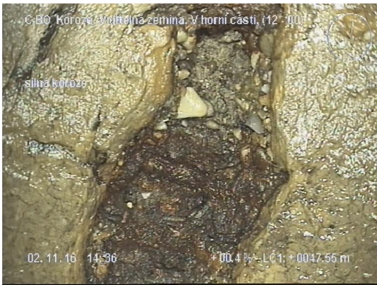
Obr. 7.25 Obrázek z kamerového průzkumu [11]
