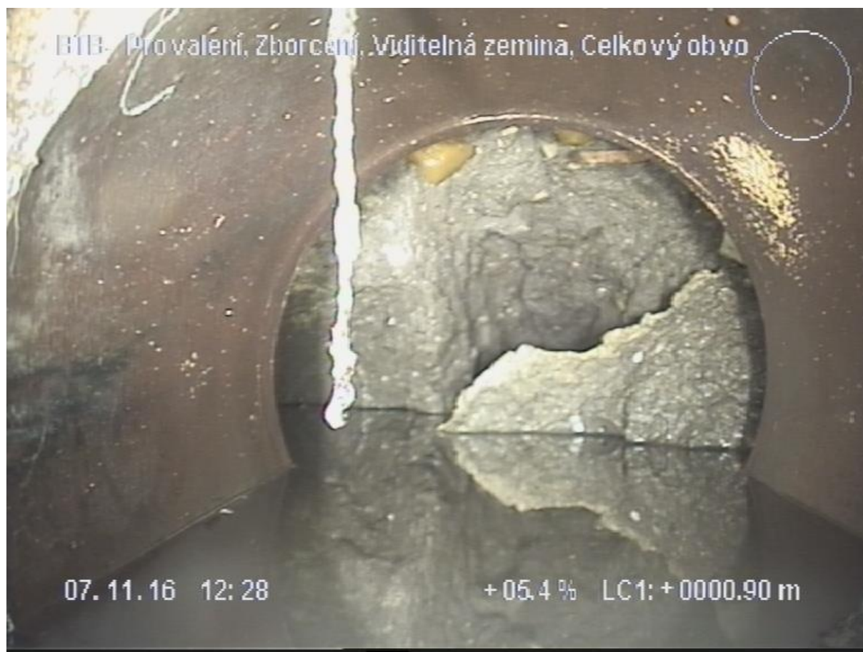
Obr. 7.27 Obrázek z kamerového průzkumu [11]
