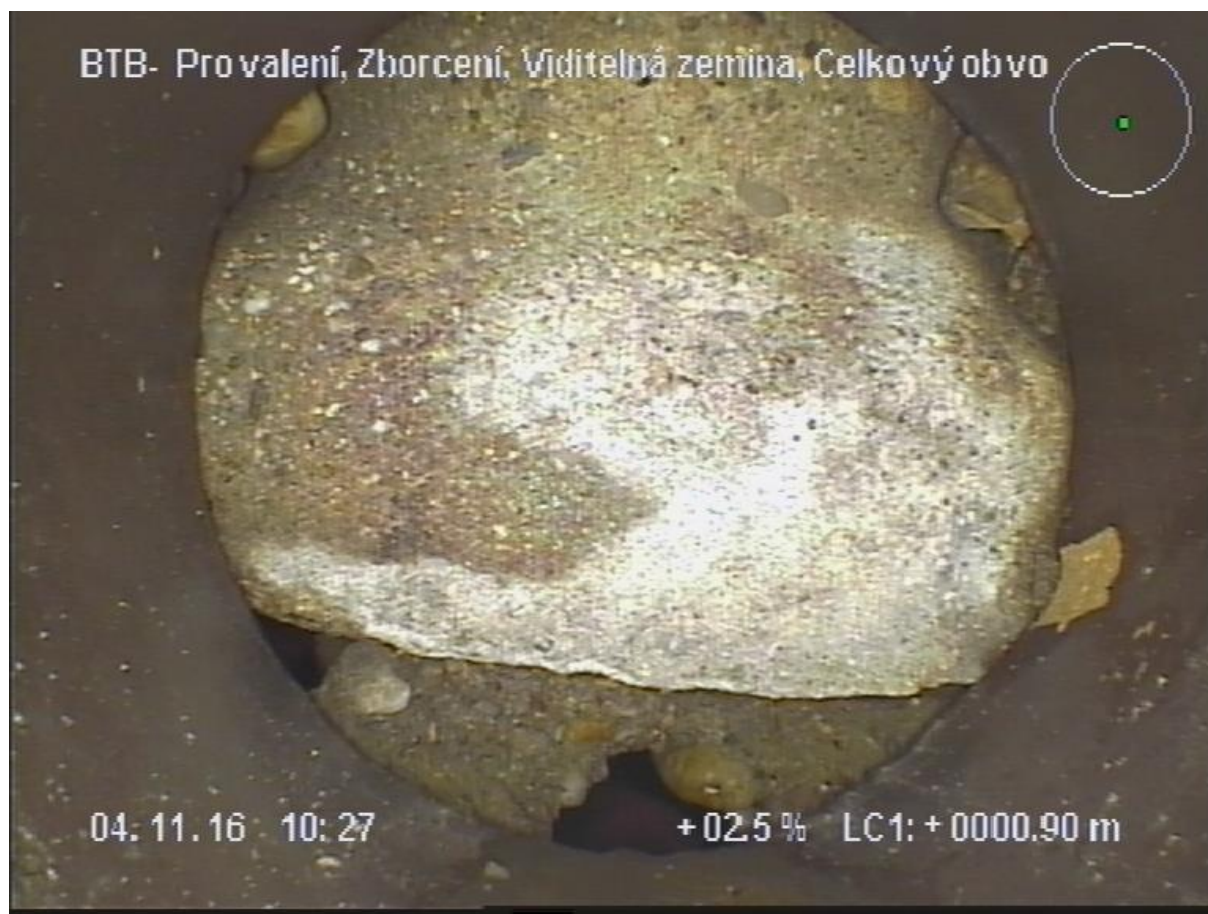
Obr. 7.18 Obrázek z kamerového průzkumu [11]
