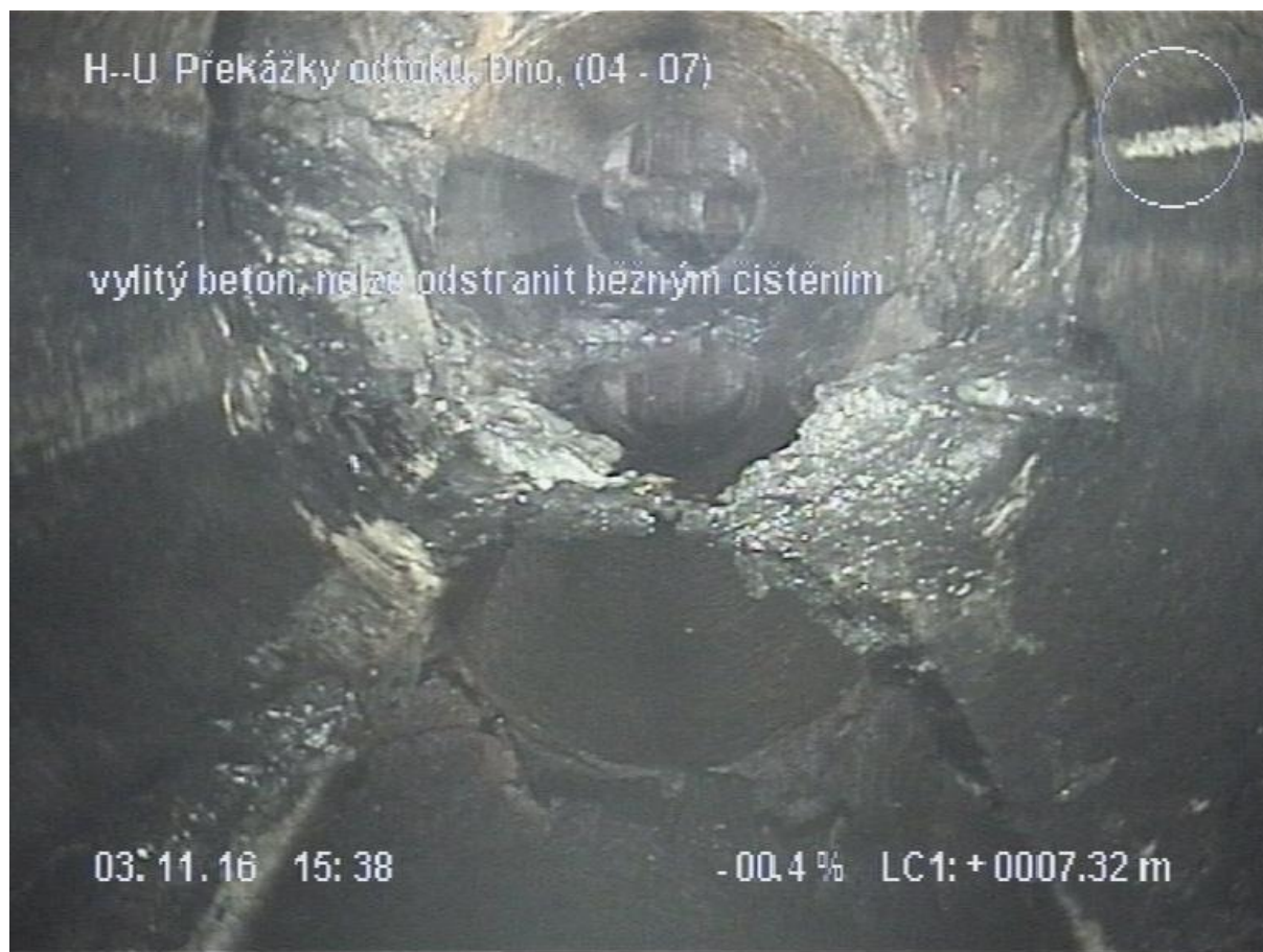
Obr. 7.32 Obrázek z kamerového průzkumu [11]
