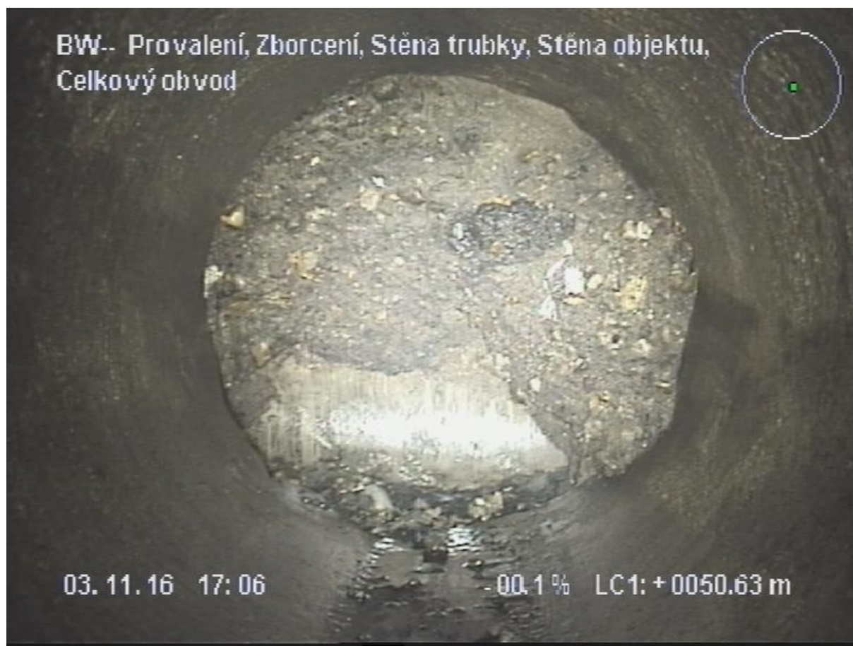
Obr. 7.33 Obrázek z kamerového průzkumu [11]
