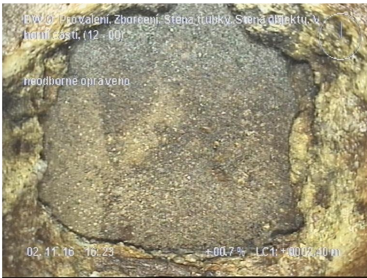
Obr. 7.34 Obrázek z kamerového průzkumu [11]
