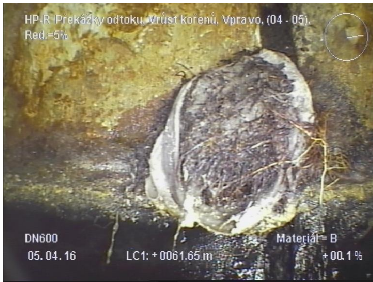
Obr. 7.2 Obrázek z kamerového průzkumu [11]
