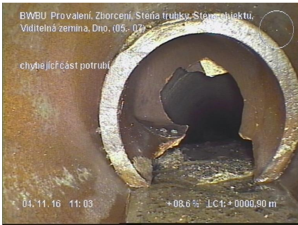
Obr. 7.20 Obrázek z kamerového průzkumu [11]
