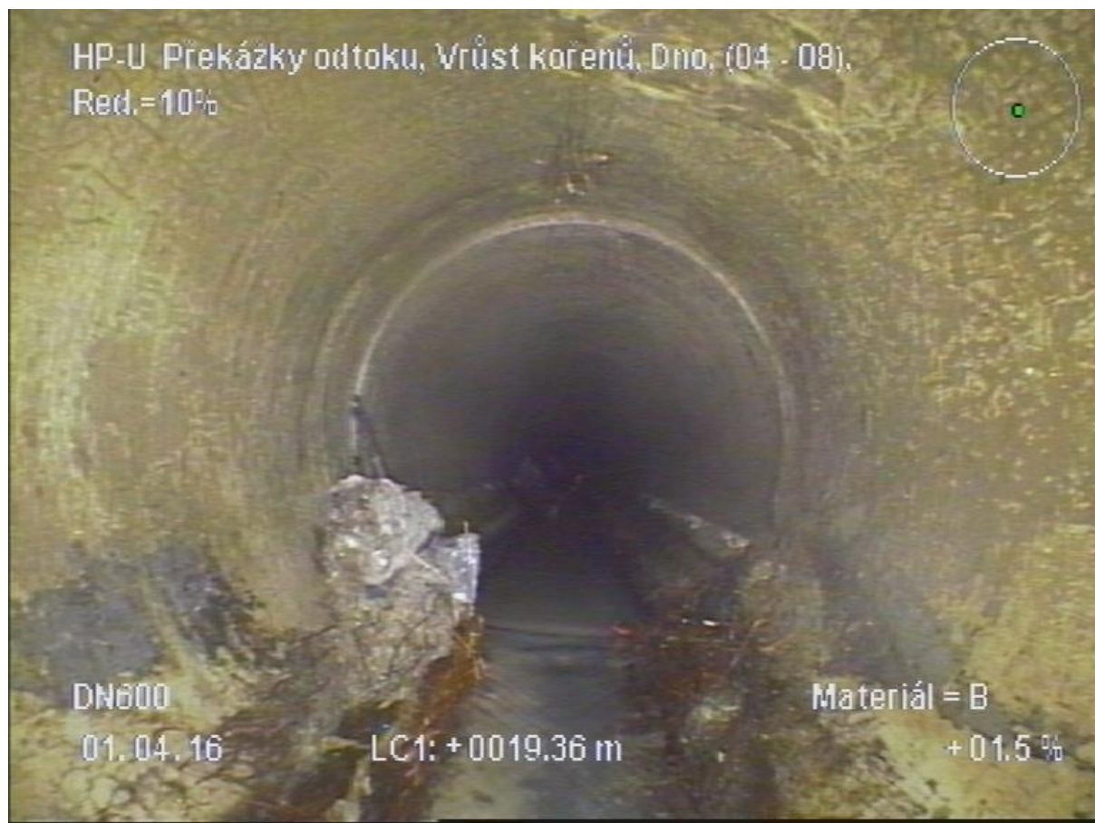
Obr. 7.5 Obrázek z kamerového průzkumu [11]
