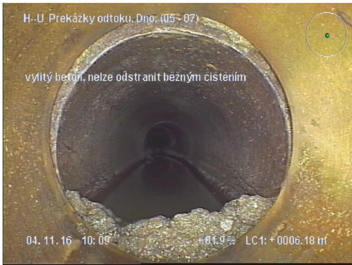
Obr. 7.16 Obrázek z kamerového průzkumu [11]
