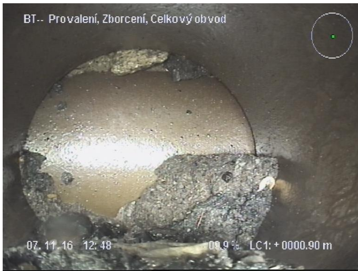
Obr. 7.28 Obrázek z kamerového průzkumu [11]
