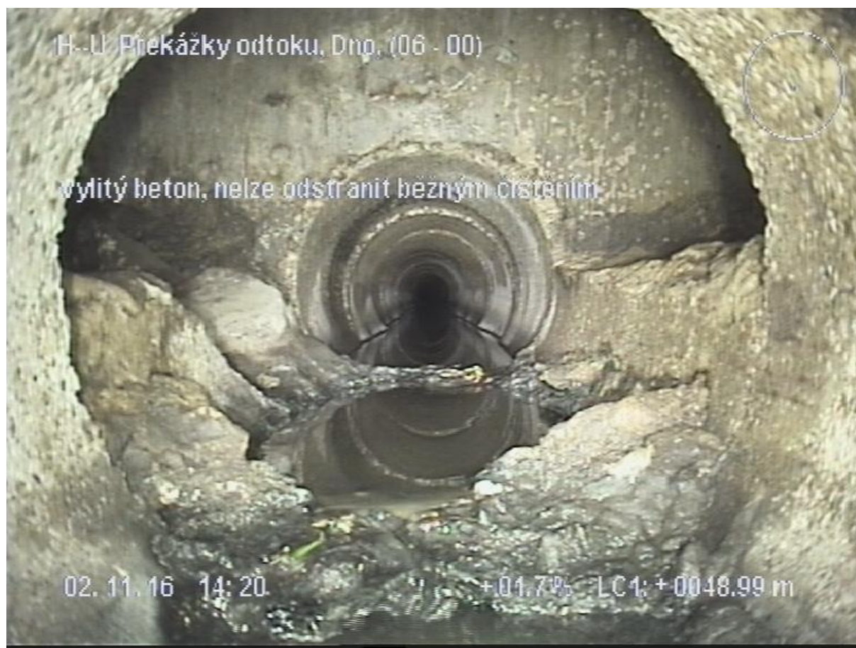
Obr. 7.22 Obrázek z kamerového průzkumu [11]
