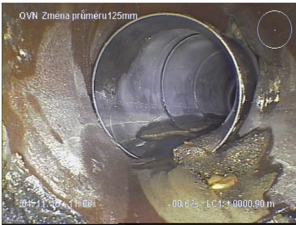
Obr. 7.19 Obrázek z kamerového průzkumu [11]
