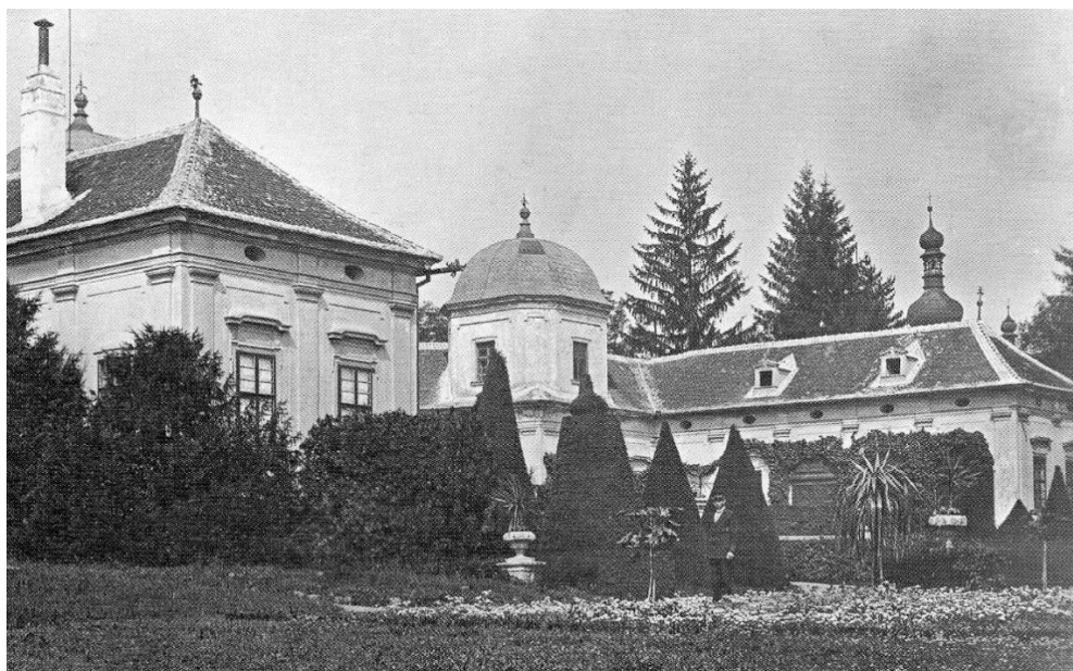
4. Horní budova zámku v Buchlovicích zvaná „Flora“, 1904
