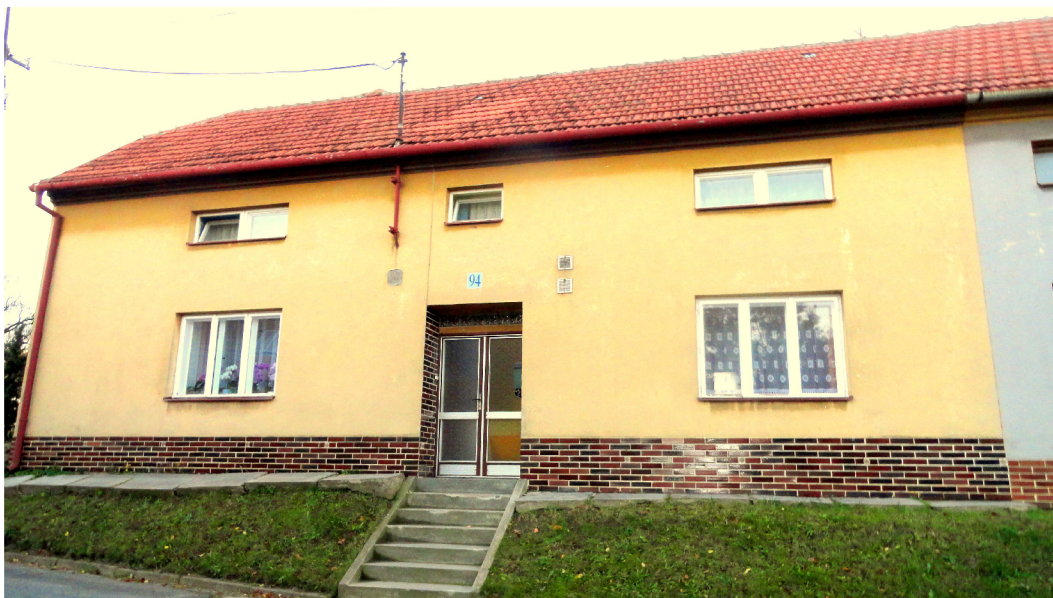
Obr. č. 12: Posuzovaná objekt – pohled od hlavní silnice
