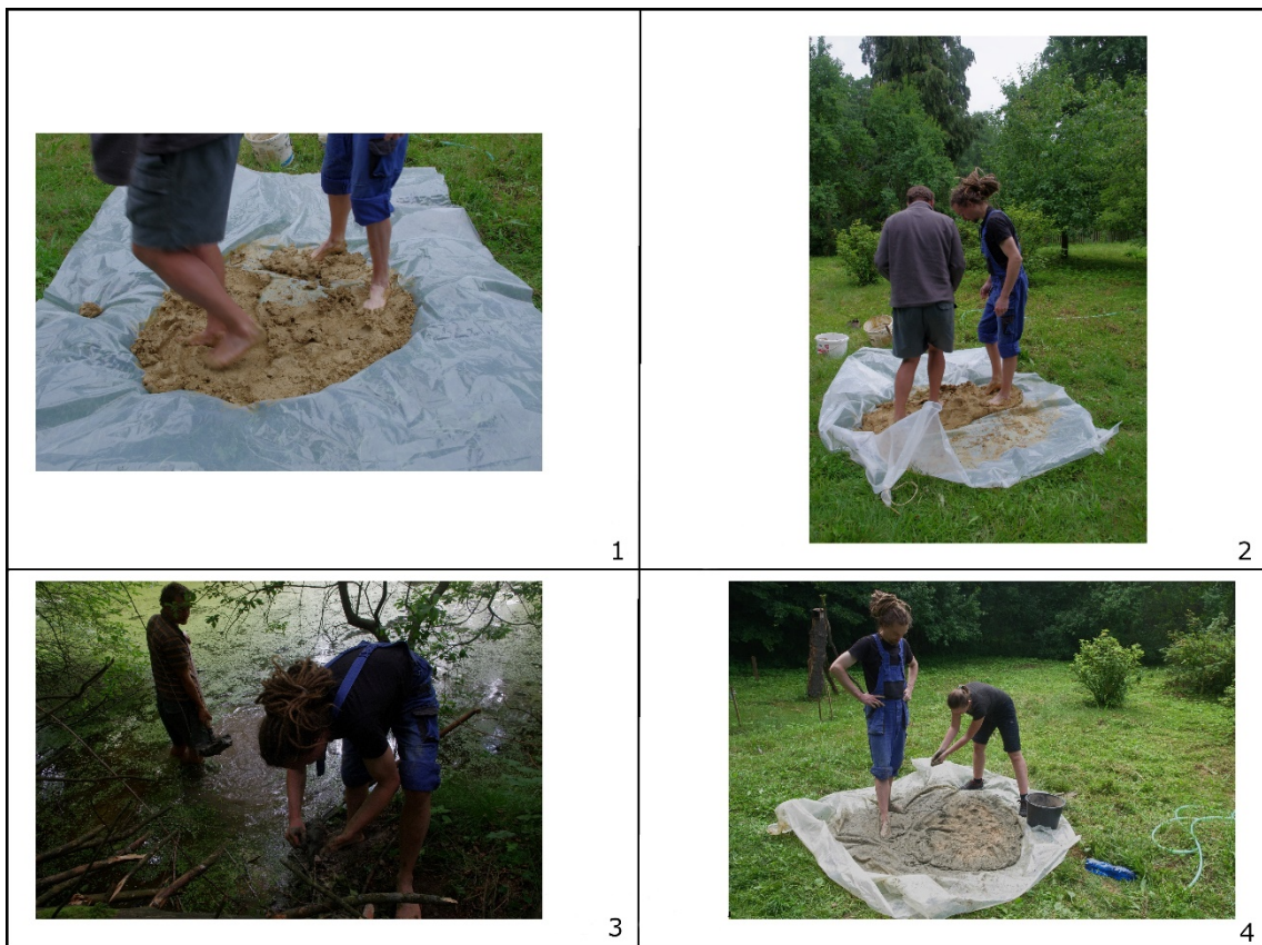
Obr. 13 Příprava materiálu. 13:1, 13:2 – hnětení materiálu prošlapáváním; 13:3 – těžení hlíny z rybníka; 13:4 – přidávání ostriva (foto Markéta Augustýnová).
