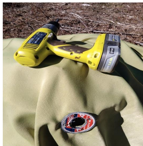
Obr. 11: Instalace plastových podložek
