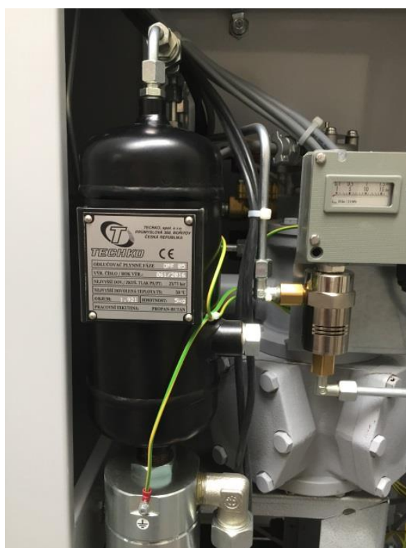
Obr. 3 Výdejní stojan LPG detail
