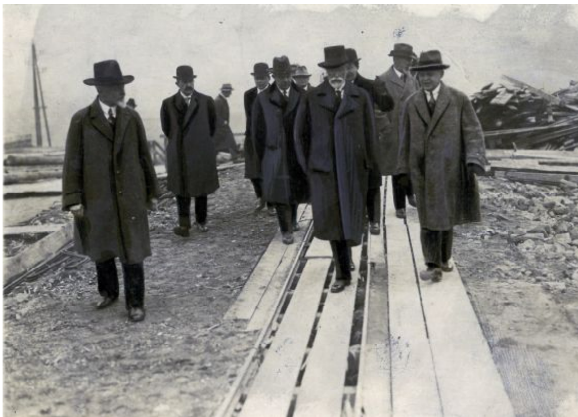
26. Návštěva T. G. Masaryka na stavbě Hlávkovyho mostu, František Mencl úplně vpravo, asi 1910. Fotoarchiv rodiny.
