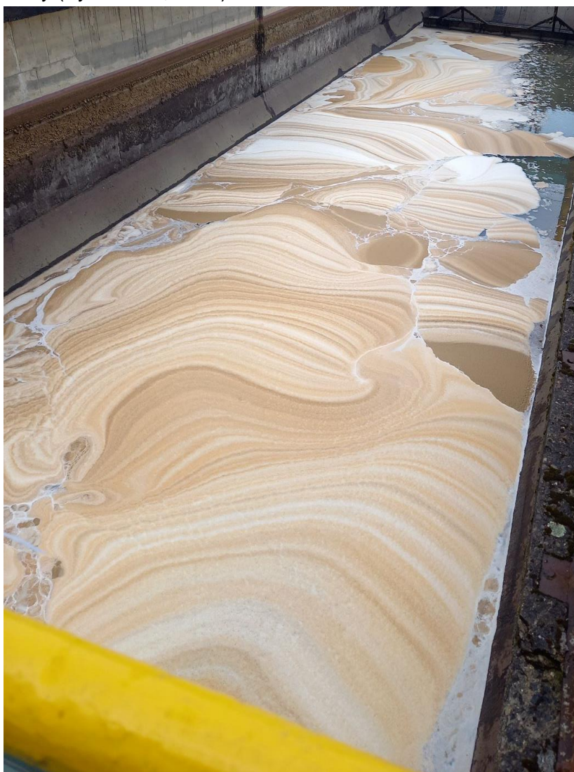
Obrázek 6: Sedimentační zdrž s mostovými shrabováký
