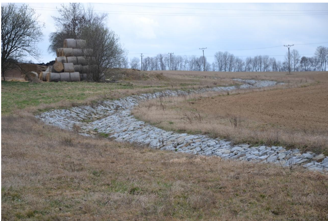
Foto č. 5: Obtokový kanál u Budějovické silnice, foto: Tomáš Petr
