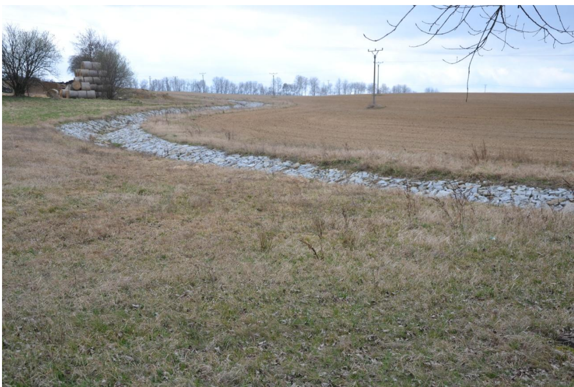
Foto č. 6: Obtokový kanál u Budějovické silnice, foto: Tomáš Petr
