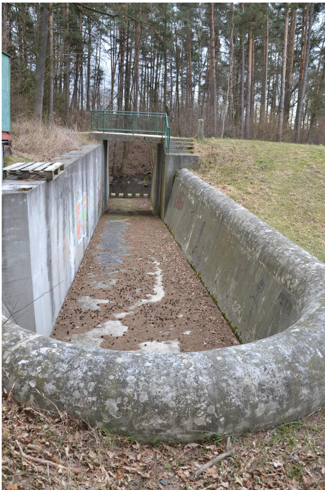
Foto č. 12: Kačerovec – bezpečnostní přeliv a vývařiště s rozražeči, foto: Tomáš Petr
