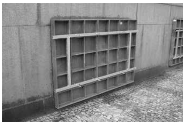
Obr. č. 7: Deska na ocelové konstrukci, zdroj: Lekosta s.r.o.
