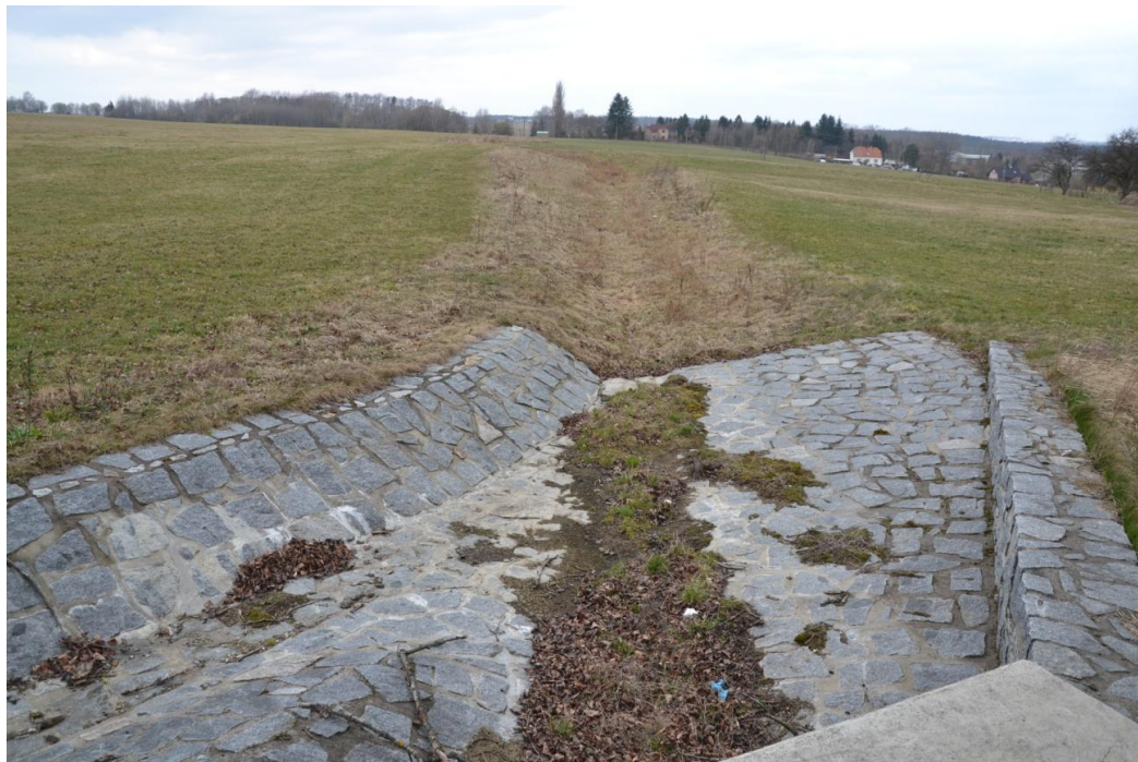
Foto č. 1: Začátek obtokového kanálu u Trocnovské silnice, foto: Tomáš Petr
