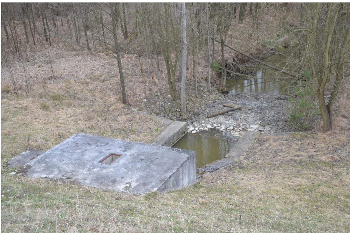
Foto č. 9: Kačerovec – Pohled na výpustný objekt, foto: Tomáš Petr
