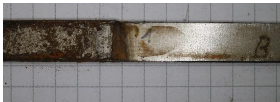
Obr. 85 Koroze na vzorku B
