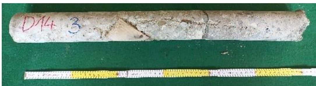
Obrázek 56: Fotodokumentace vývrtu ze sloupu D14
