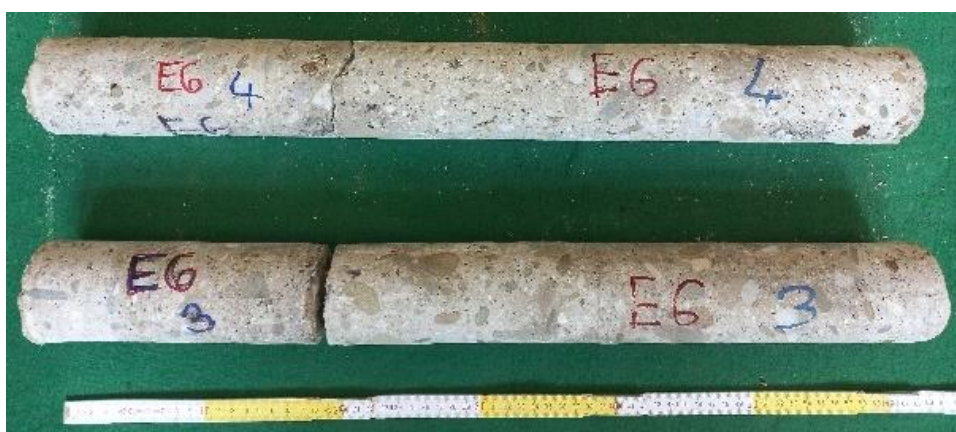
Obrázek 58: Fotodokumentace vývrtů ze sloupu E6
