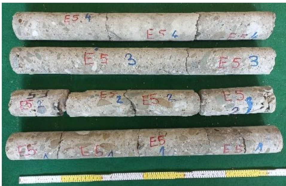
Obrázek 57: Fotodokumentace vývrtů ze sloupu E5
