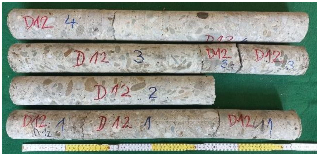
Obrázek 54: Fotodokumentace vývrtů ze sloupu D12
