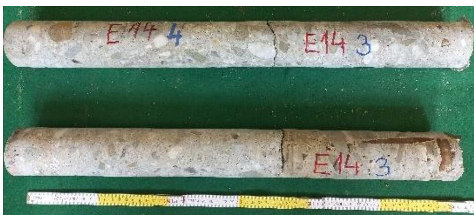
Obrázek 59: Fotodokumentace vývrtů ze sloupu E14
