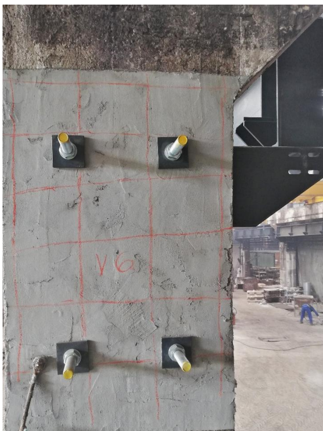
Obrázek 4: Opatření pro zvýšení únosnosti sloupu [20]
