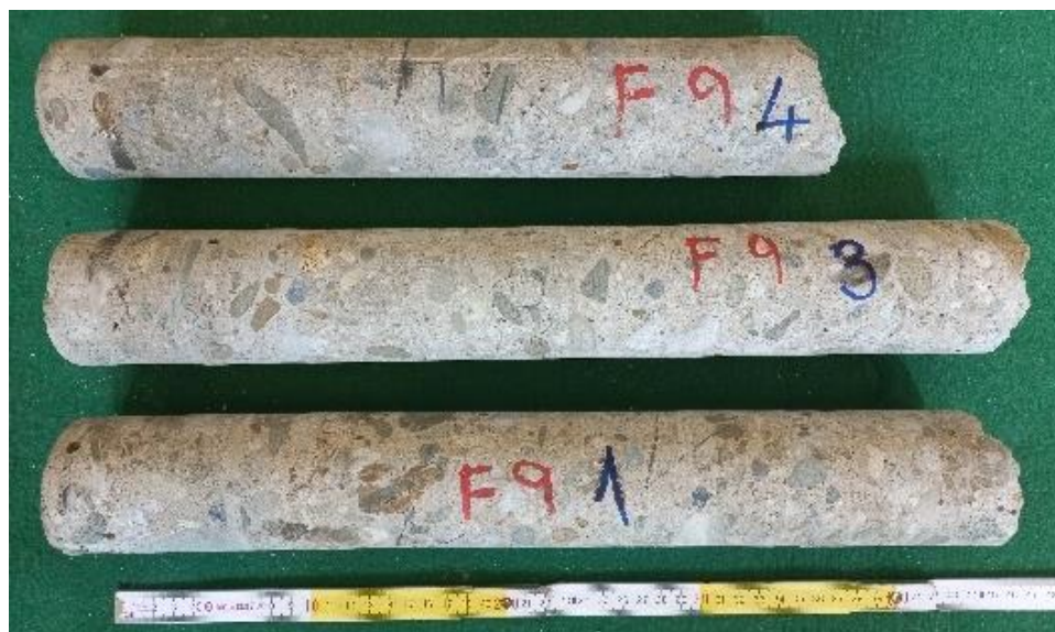
Obrázek 62: Fotodokumentace vývrtů ze sloupu F9
