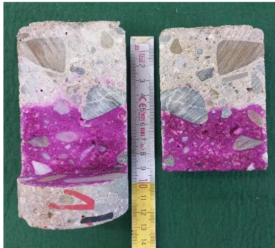
Obrázek 18: Rozřezaný vzorek s fenolftaleinem potvrzujícím karbonataci
