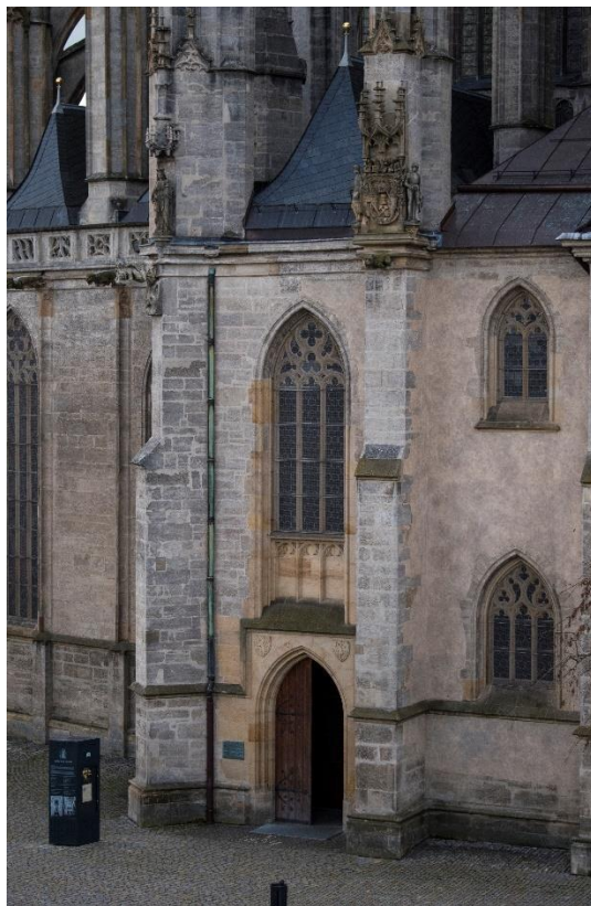
Obr. 26: Severní rameno, portál
