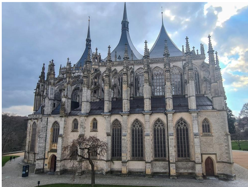
Obr. 9: Opěrný systém, severní strana
