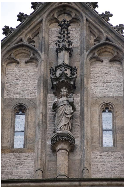
Obr. 53: Socha sv. Barbory na štítu západního průčelí
