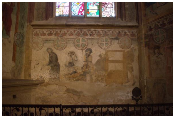
Obr. 69: Hašplířská kaple – nástěnná malba
