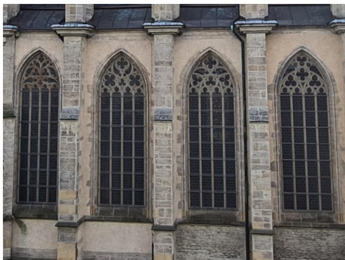
Obr. 18: Gotická okna v přízemí
