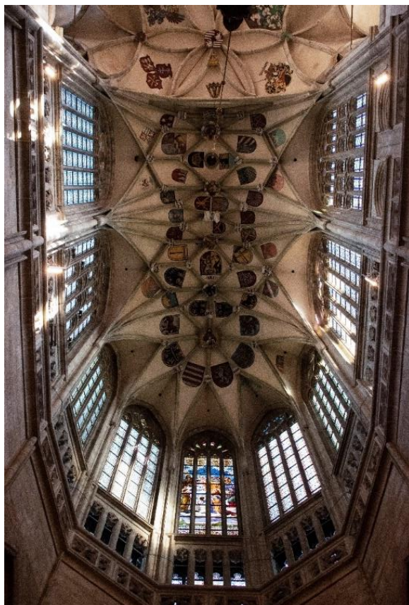
Obr. 74: Síťová klenba nad kněžištěm od Matyáše Rejska
