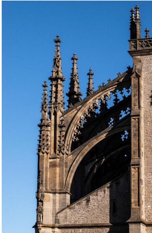
Obr. 11: Opěrné oblouky a piliře
