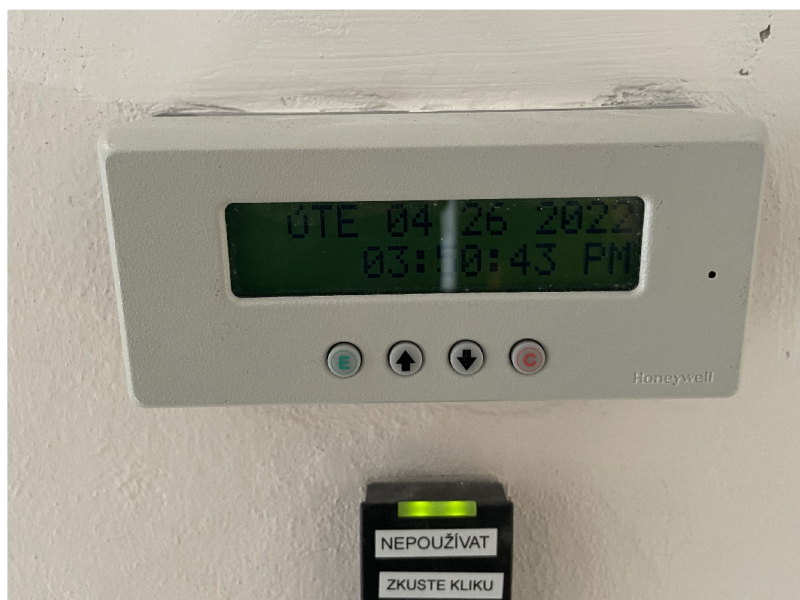
Obrázek 2.2: Použití znakového LCD displeje v zabezpečovacím systému
