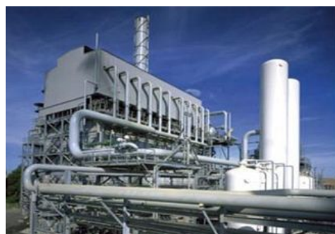
Obrázek 8 Parní reformování zemního plynu
