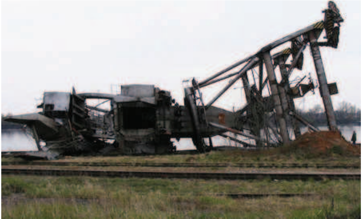
Obr. 31 Poškozený přístavní jeřáb na Slovensku (41)
