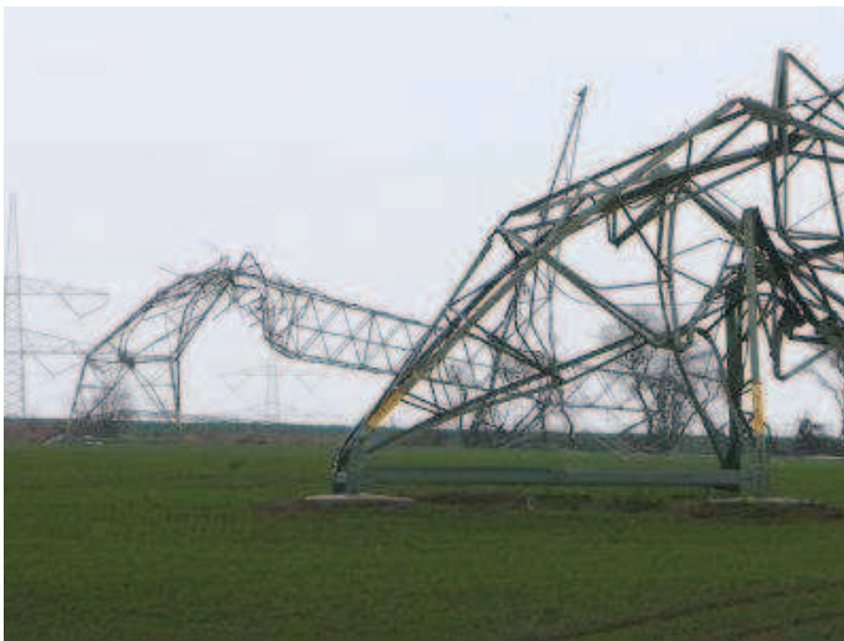
Obr. 17 Poničené sloupy vysokého napětí (47)
