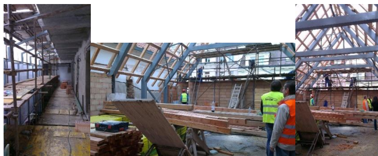
Obrázek 6: Stavba Studiové scény
