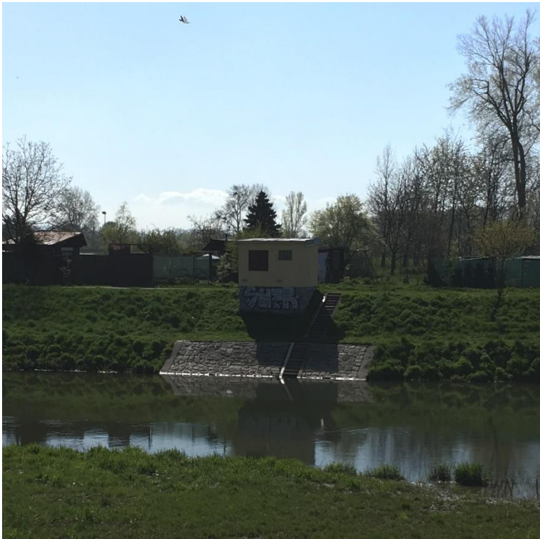
Obr. 8: Vodoměrná stanice Olomouc – Nové Sady (Filip Coufal, duben 2016)
