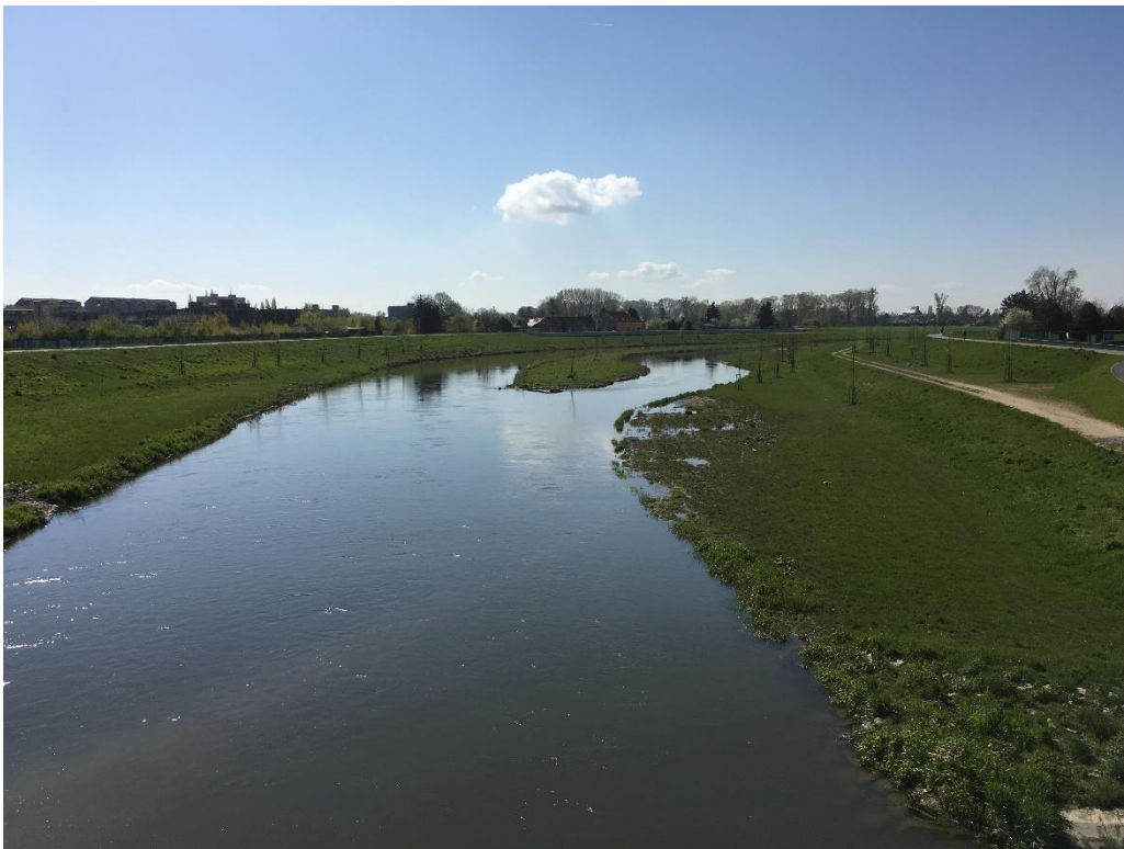
Obr. 14: Pohled na upravené koryto řeky Moravy z mostu Velkomoravská – po směru toku řeky (Filip Coufal, duben 2016)
