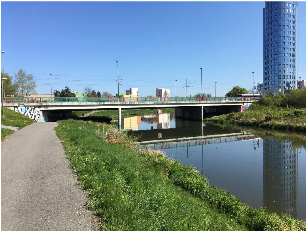
Obr. 24: Pohled na silniční most na tř. Kosmonautů (Filip Coufal, duben 2016)
