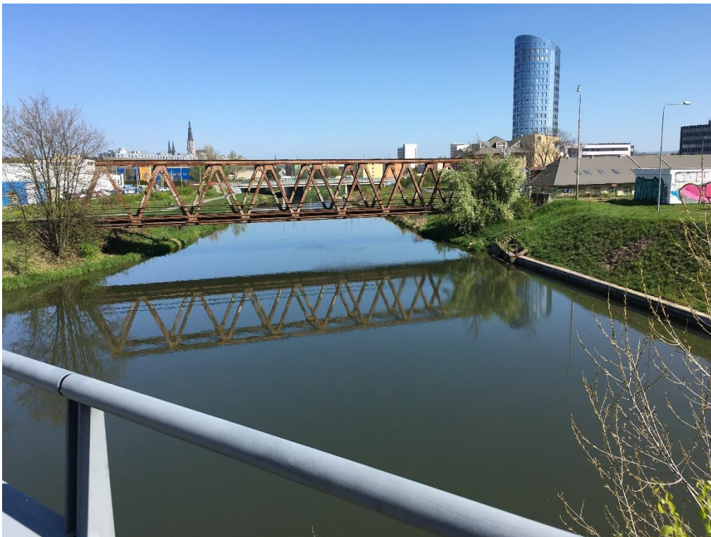
Obr. 22: Železniční most „u teplárny“ – pohled ze silničního mostu na ulici Wittgensteinova (Filip Coufal, duben 2016)
