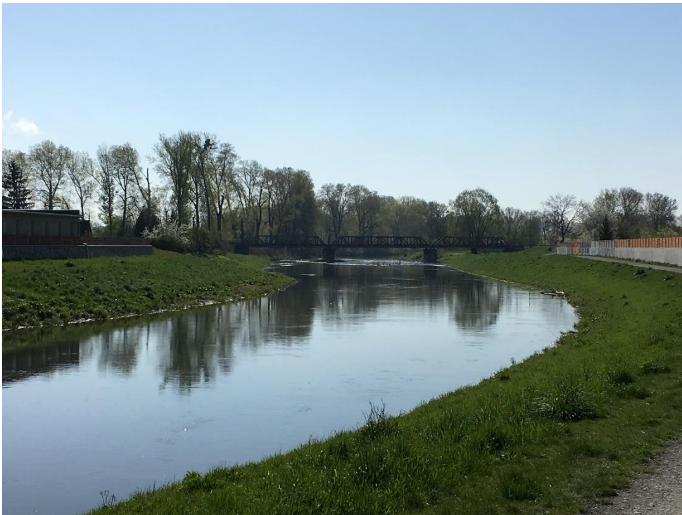
Obr. 2: Železniční most na trati Olomouc – Nezamyslice (Filip Coufal, duben 2016)
