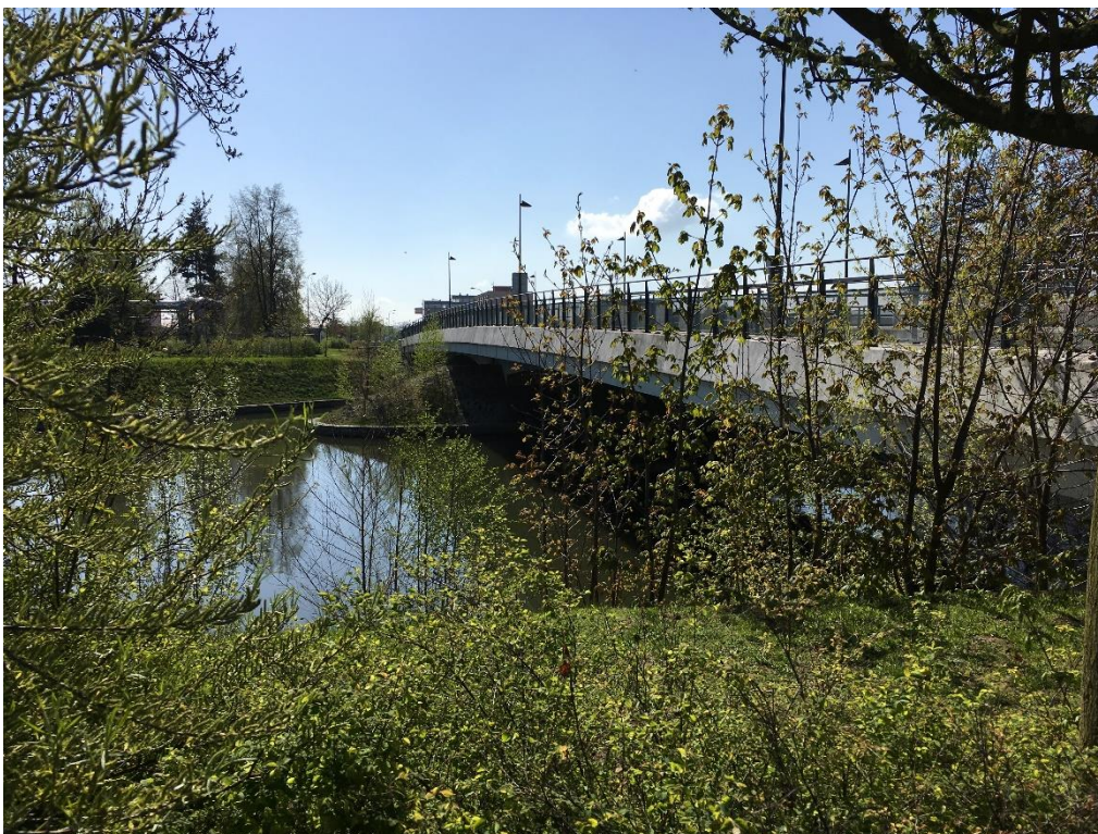
Obr. 23: Silniční most na ulici Wittgensteinova (Filip Coufal, duben 2016)
