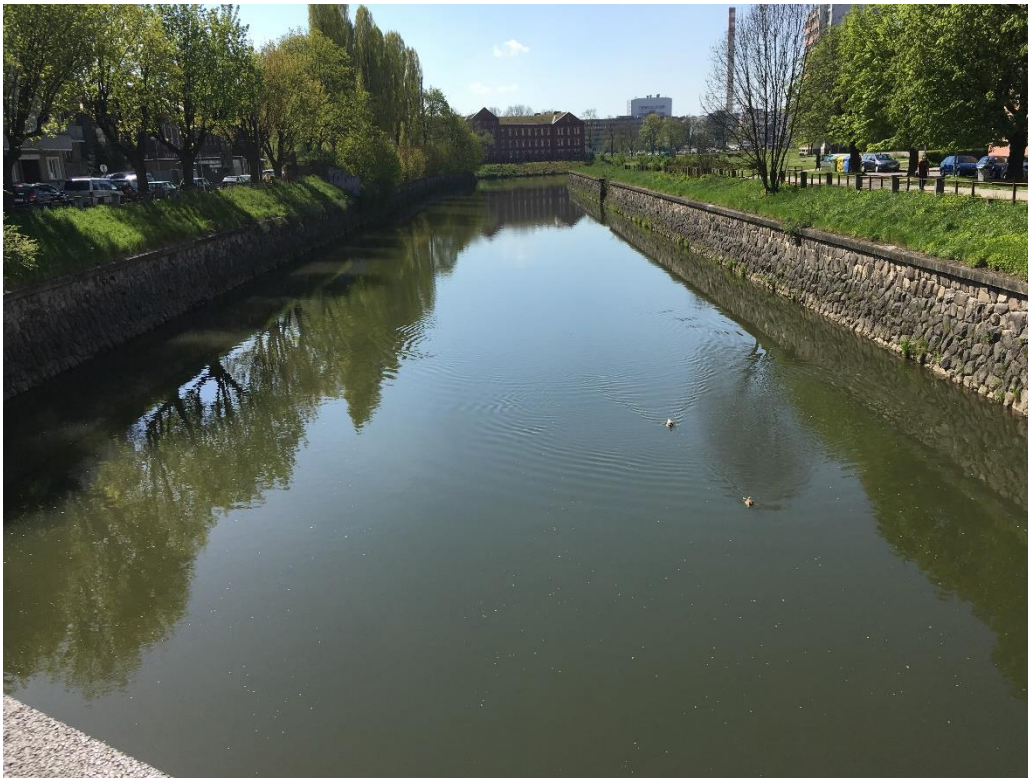
Obr. 30: Koryto řeky Moravy a nábrežní zdi – pohled z mostu na Masarykově třídě – po toku řeky Moravy (Filip Coufal, duben 2016)
