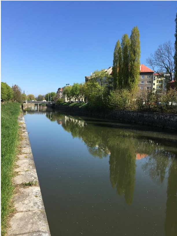
Obr. 28: Koryto řeky Moravy na úrovni vysokoškolských kolejí – ulice Šmeralova (Filip Coufal, duben 2016)
