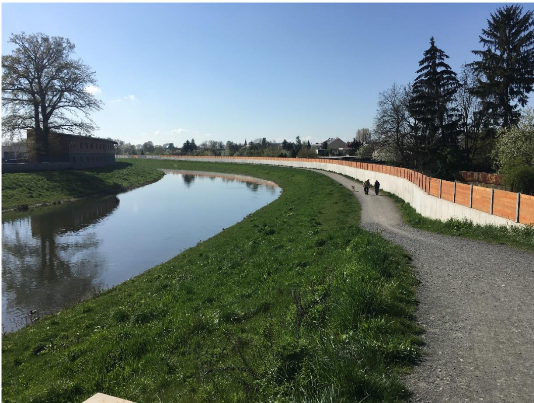
Obr. 4: Pravobřežní ochranná stěna koryta řeky Moravy na úrovni Povodí Moravy s.p. (Filip Coufal, duben 2016)
