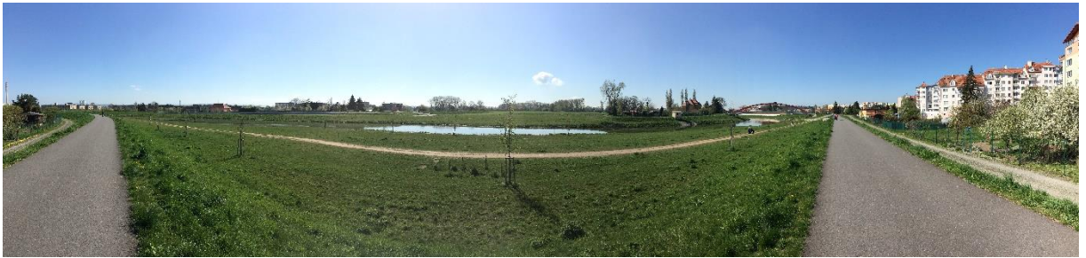
Obr. 10: Panoramatický snímek upraveného koryta řeky Moravy – pohled z ochranného valu směrem na prostor pro inundaci (Filip Coufal, duben 2016)
