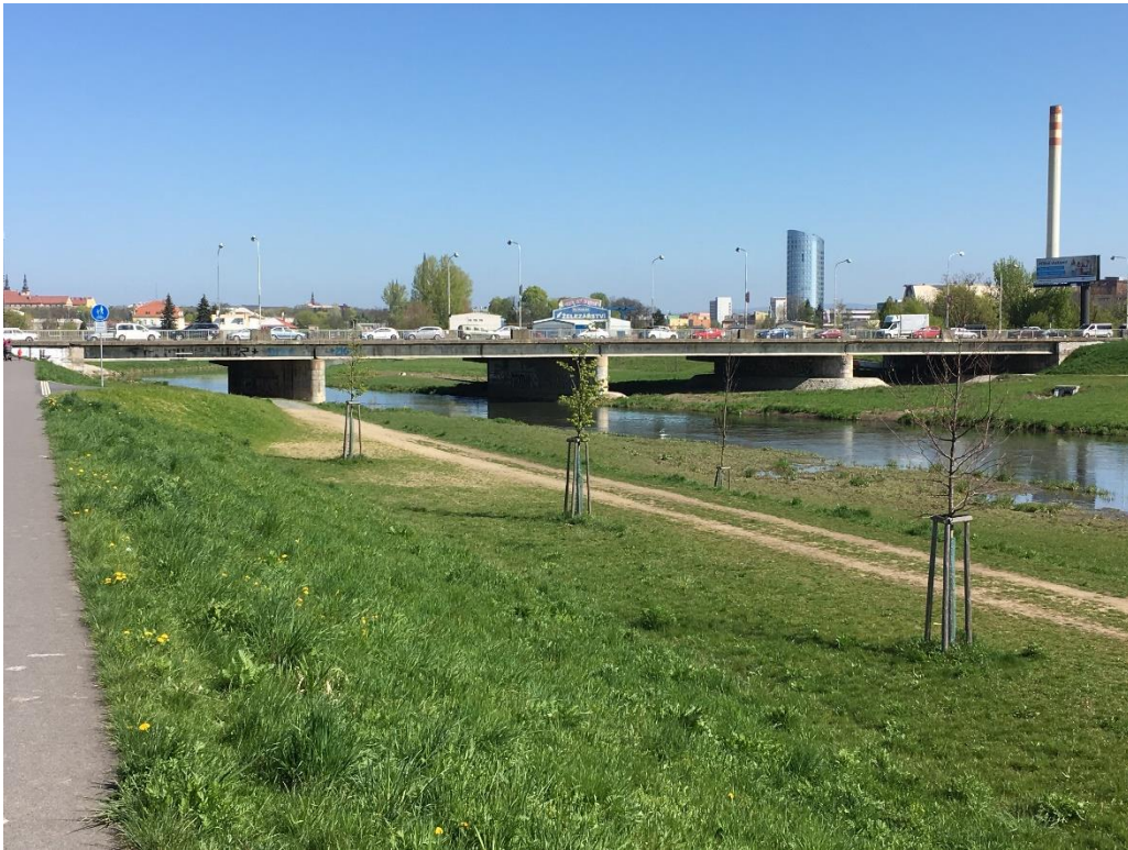
Obr. 13: Silniční most na ulici Velkomoravská (Filip Coufal, duben 2016)
