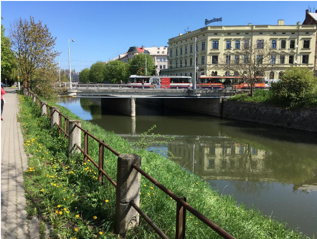
Obr. 29: Silniční most na Masarykově tř. (Filip Coufal, duben 2016)
