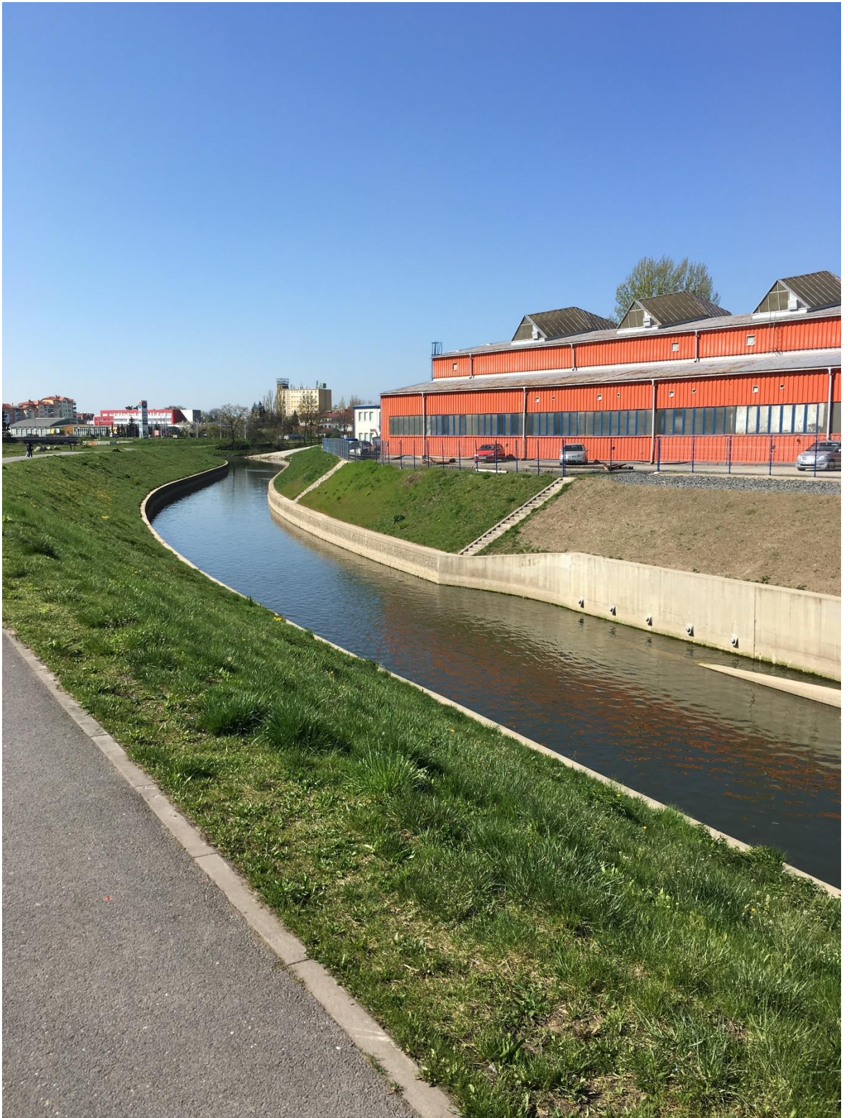
Obr. 19: Obtokový kanál vybudovaný v rámci I. etapy protipovodňové ochrany města Olomouce – pohled po směru toku (Filip Coufal, duben 2016)
