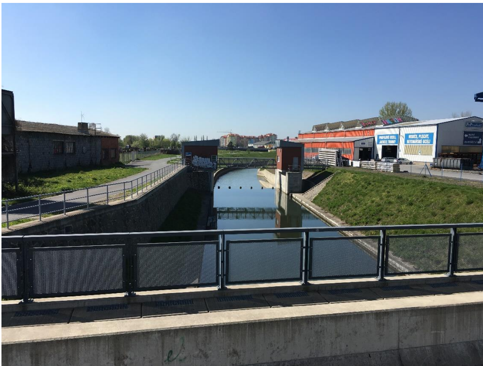
Obr. 21: Pohled na obtokový kanál a jez vybudovaný v rámci I. etapy protipovodňové ochrany města – pohled po toku řeky (Filip Coufal, duben 2016)
