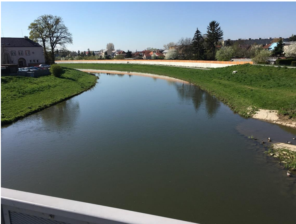
Obr. 6: Koryto řeky Moravy s pravobřežní ochrannou stěnou, na levé straně podnik Povodí Moravy s.p. (Filip Coufal, duben 2016)
