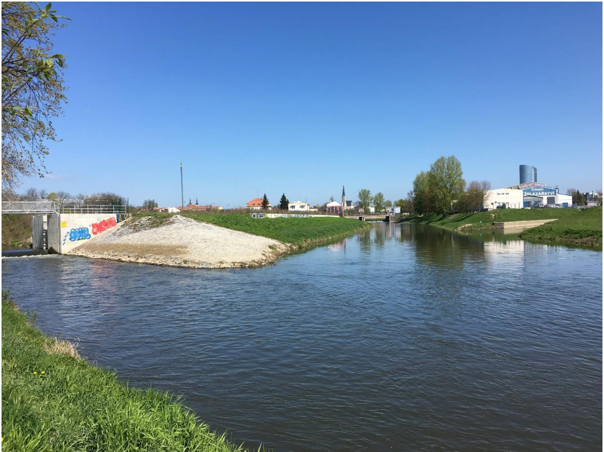
Obr. 40: Soutok Mlýnského Potoka (vlevo), řeky Moravy (uprostřed) a obtokového kanálu (vpravo) u silničního mostu na ulici Velkomoravská (Filip Coufal, duben 2016)
