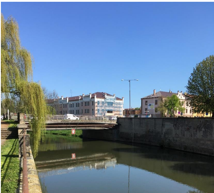
Obr. 34: Silniční most na ulici Komenského (Filip Coufal, duben 2016)
