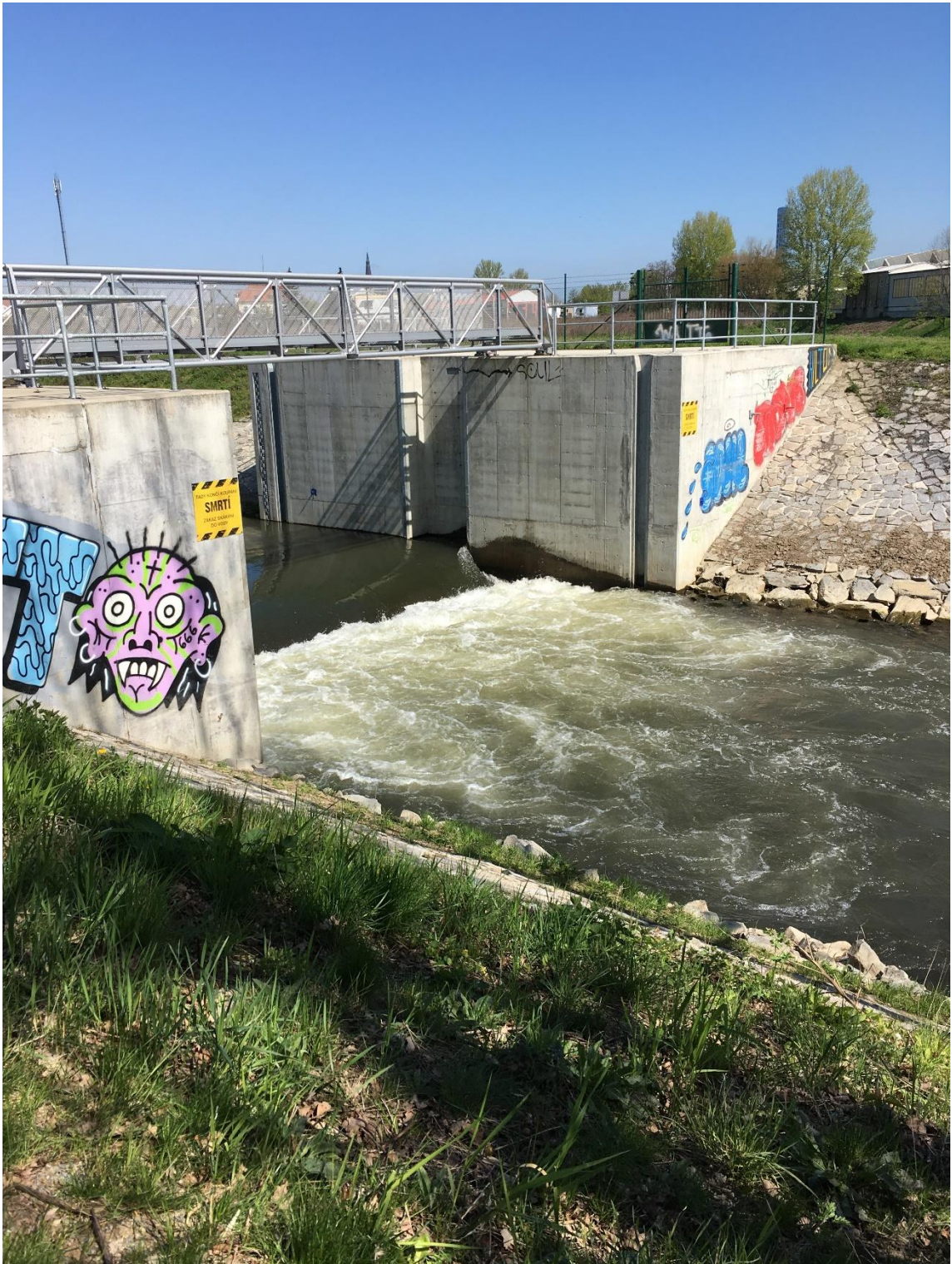
Obr. 39: Pohled na pohyblivý uzávěr, který byl vybudován v rámci II. a etapy protipovodňové ochrany města Olomouce (Filip Coufal, duben 2016)
