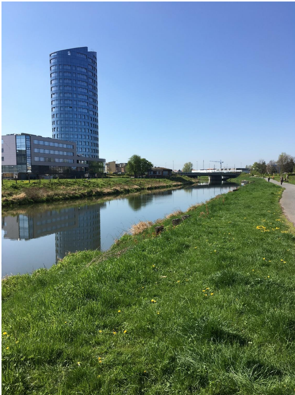
Obr. 26: Koryto řeky Moravy na úrovni budovy BEA centrum Olomouc – pohled po směru toku řeky Moravy (Filip Coufal, duben 2016)
