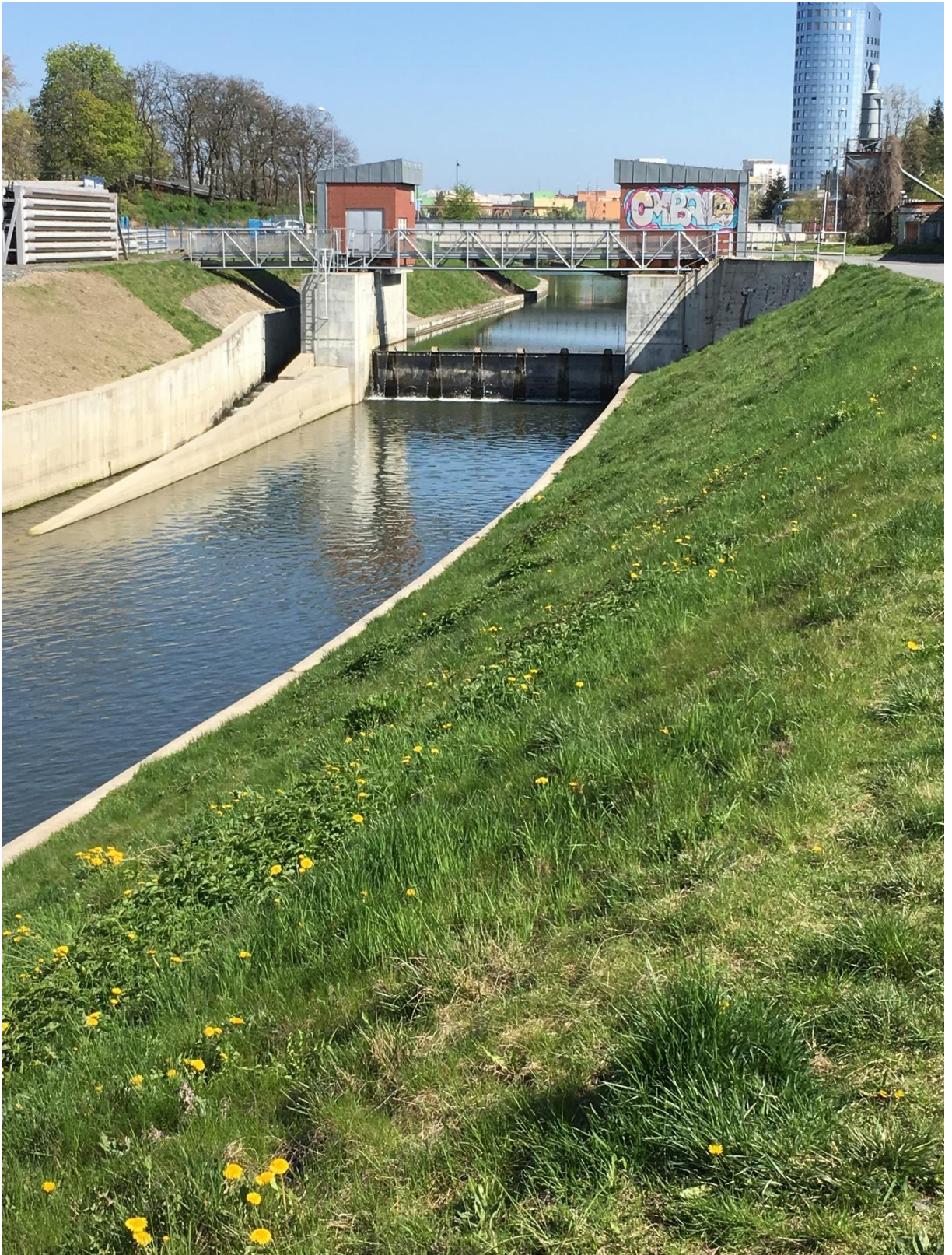
Obr. 18: Jez na obtokovém kanále vybudovaný v rámci I. etapy protipovodňové ochrany města Olomouce (Filip Coufal, duben 2016)
