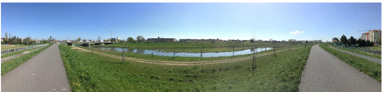
Obr. 12: Panoramatický snímek upraveného koryta řeky Moravy – pohled na levobřežní ochrannou hráz (Filip Coufal, duben 2016)
