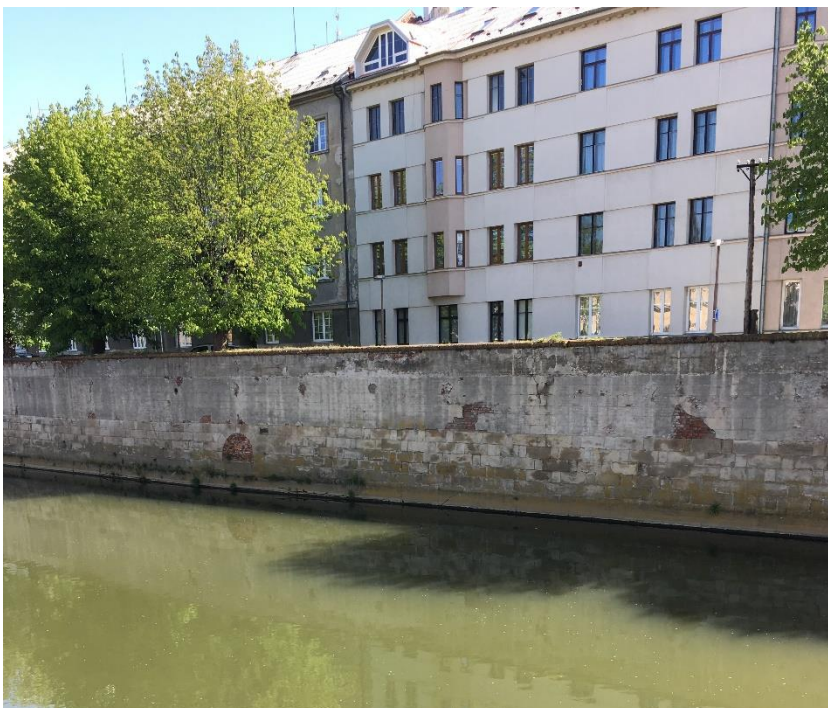
Obr. 32: Detail nábrežní zdi (Filip Coufal, duben 2016)
