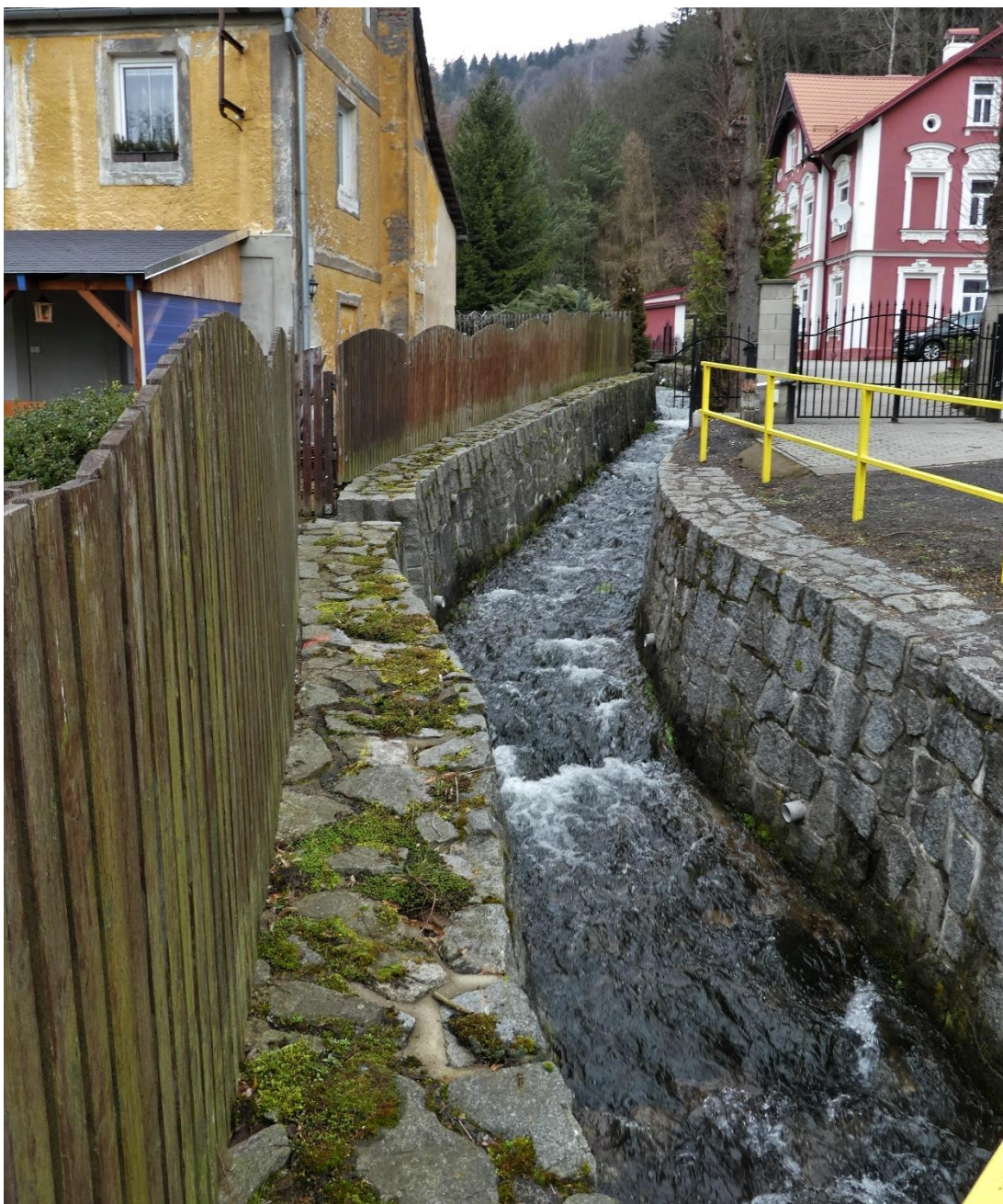
Obrázek 21 Zděné koryto v obci Perštejn, 2020.
