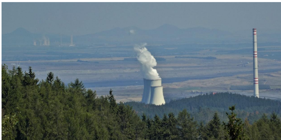
Obrázek 9 Elektrárna Pruněřov. Foceno z území zaniklé vsi Venkov v povodí Širokého potoka, 2019.
