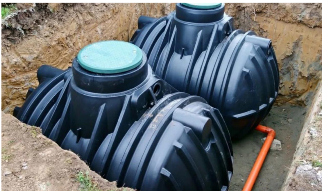
Obrázek 6 – Retenční nádrže (ČOV BEZ ÚŘADU)
