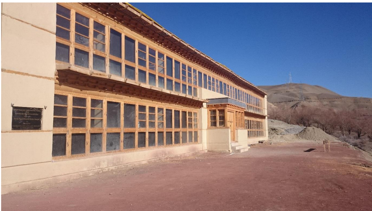
Obr. 1.7: Budova školského internátu
