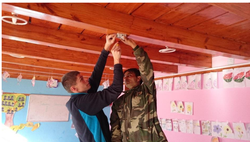
Obr. 2.2: Inštalácia čidiel na strop
