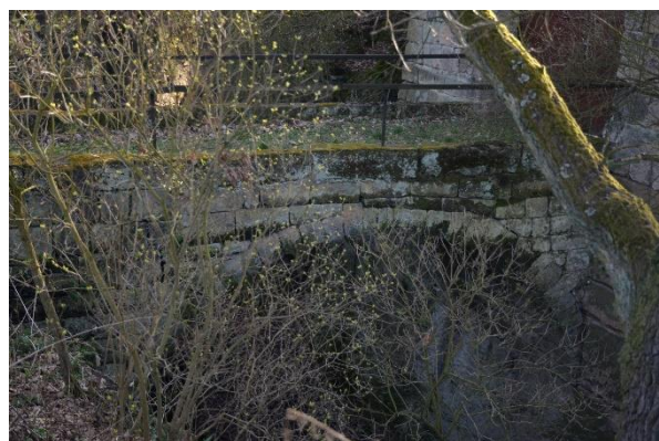
Obr. č. 49: Most Rybnov 03
