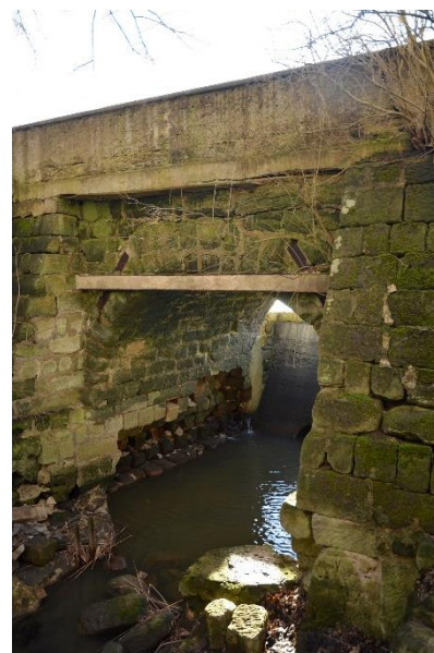
Obr. č. 45: Most Rybnov 02
