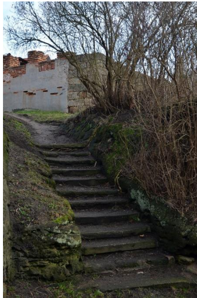
Obr. č. 81: Schodiště Holany 01
