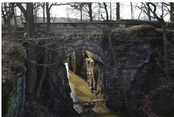
Obr. č. 50: Most Mnichovská průrva 01
