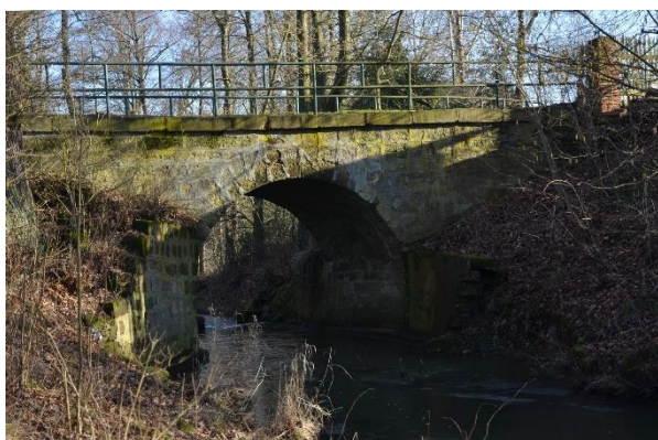
Obr. č. 48: Most Rybnov 01
