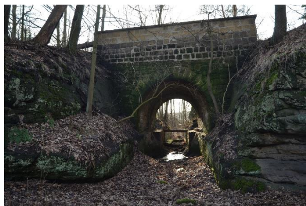
Obr. č. 51: Most Mnichovská průrva 02
