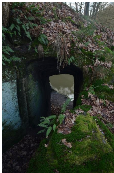
Obr. č. 76: Schodiště Mníchovská průrva 01
