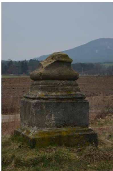
Obr. č. 19: Podstavec pod Křížek Sádky 01
