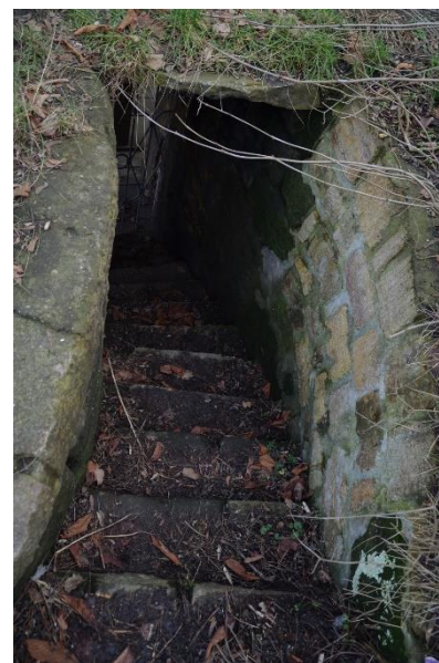
Obr. č. 77: Schodiště Novozámecká průrva 01
