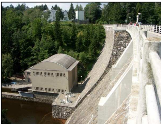
Obr. č. 6 - Hráz vodní nádrže Pastviny
