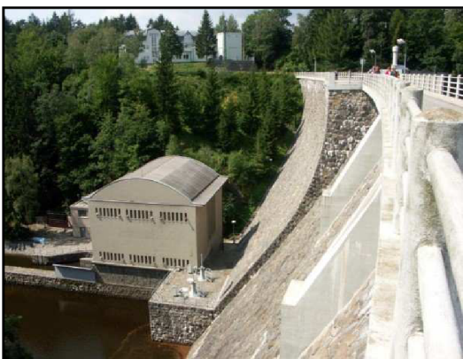
Obr. č. 6 - Hráz vodní nádrže Pastviny
