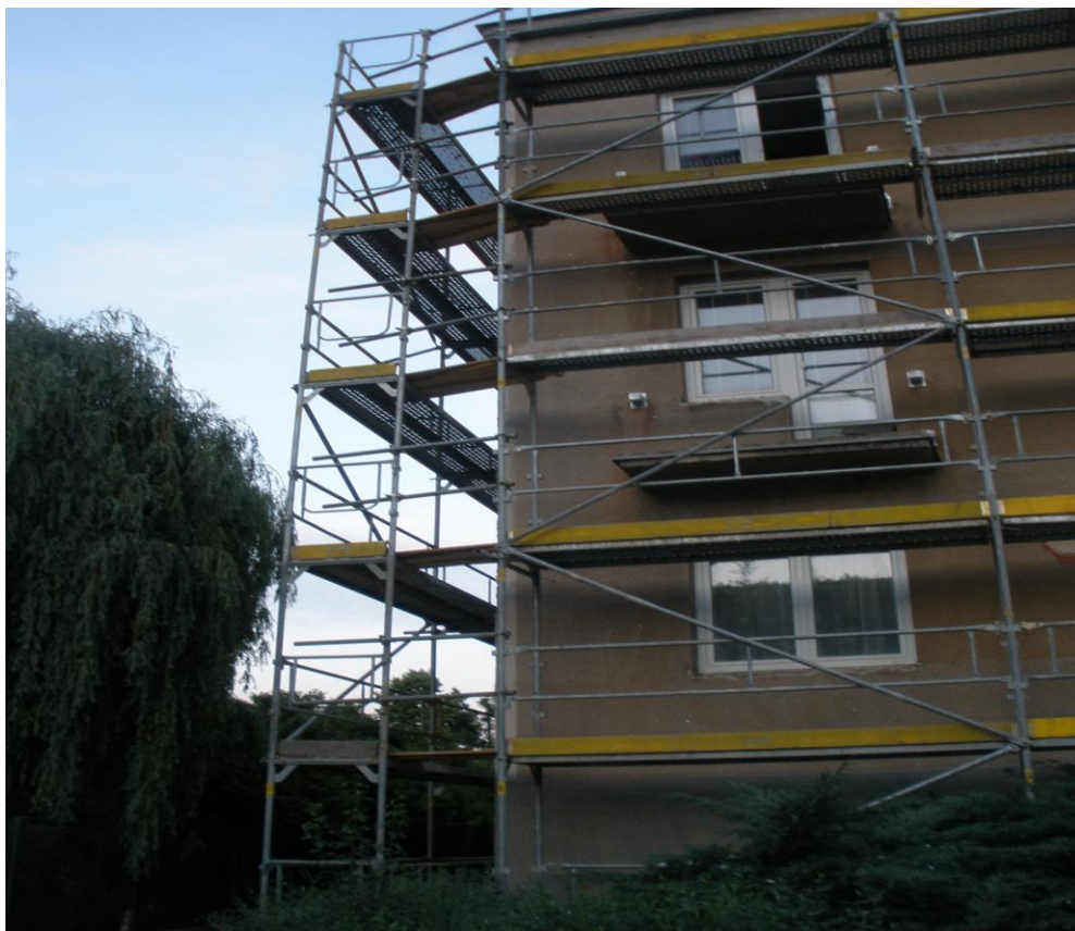
Obr. 16. Rekonstrukce panelového domu v Radotíně
