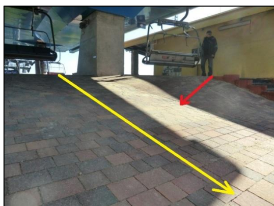
Obrázek 41. Značný příčný sklon při nástupu na lanovku ( http://cile.jedemetaky.cz/cile/pristupnost/339-lanova-draha-na-cantoryji )
