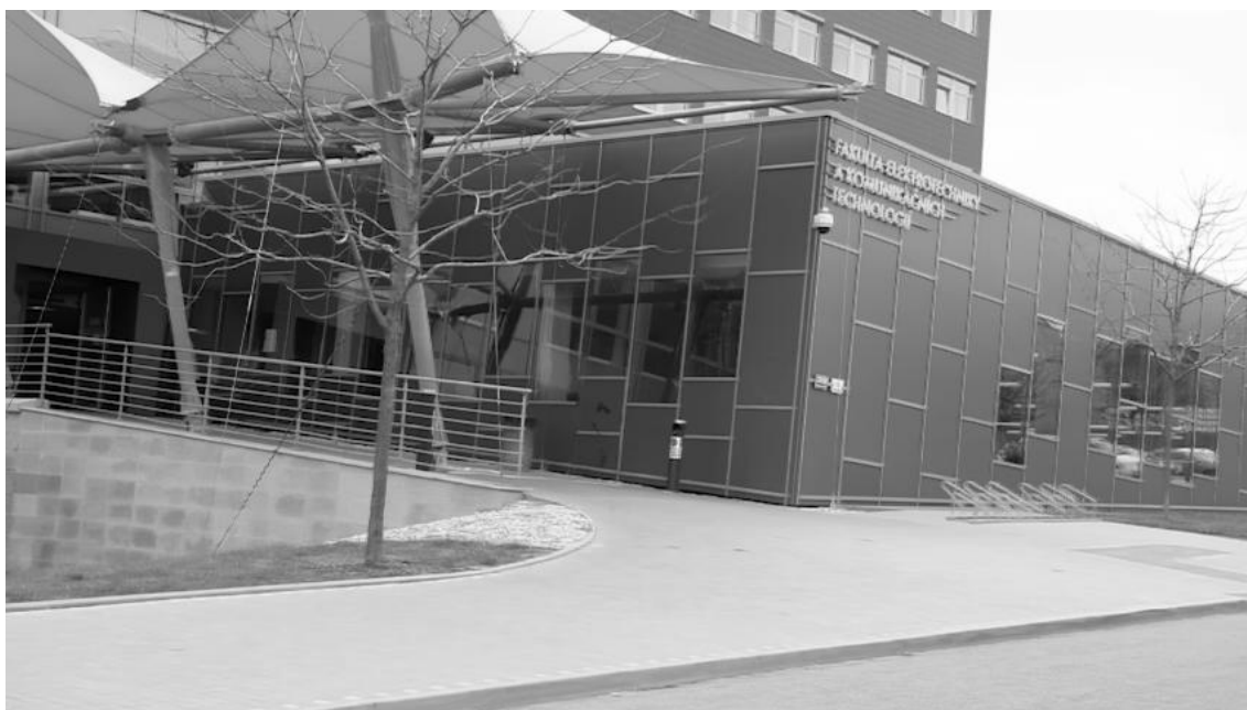
(a) Budova VUT FEKT Technická 10
