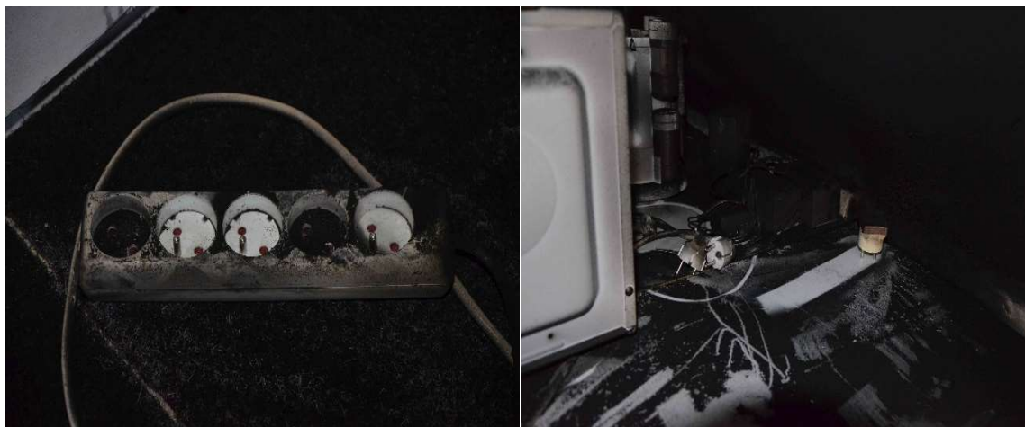
Obrázek č. 6 – Vlevo elektrická zásuvka prodlužovacího kabelu po vypojení elektrických spotřebičů majitelem domu před ohledáním místa požáru, vpravo elektrické zástrčky elektrických spotřebičů. 23
