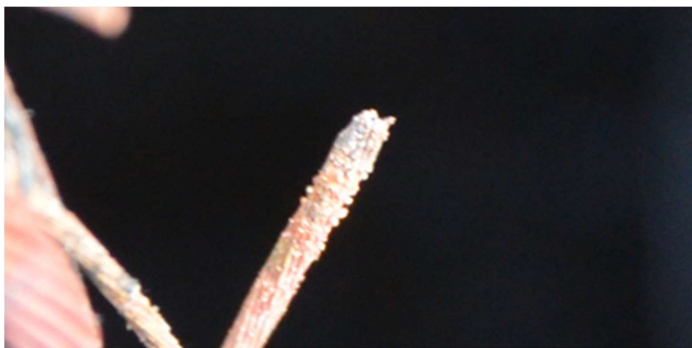
Obrázek č. 4 – Nataveniny na elektrickém vodiči. 16
