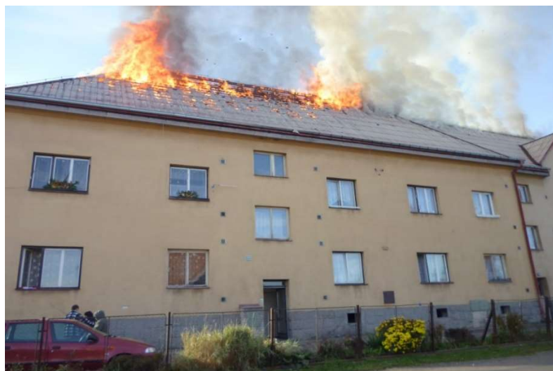
Obrázek č. 7 – svědecká fotografie požáru bytového domu. 24
