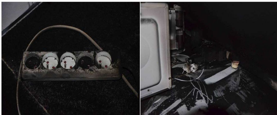
Obrázek č. 6 – Vlevo elektrická zásuvka prodlužovacího kabelu po vypojení elektrických spotřebičů majitelem domu před ohledáním místa požáru, vpravo elektrické zástrčky elektrických spotřebičů. 23
