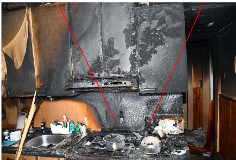
Obrázek č. 9 – ohniskový kužel v prostoru kriminalistického ohniska. 26
