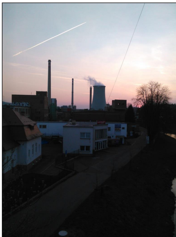
Příloha 10: Elektrárna a teplárna Alpiq Generation v údolní nivě Dřevnice, vlastní foto
