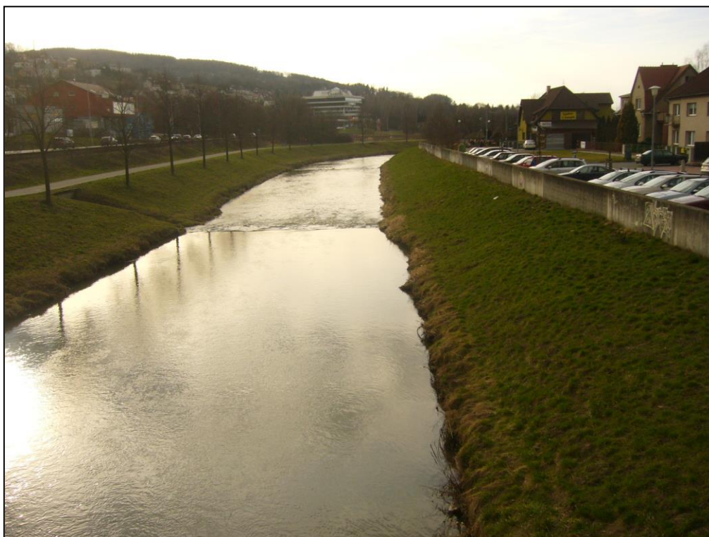
Obr. č. 24: Ochranná betonová hráz při pravém břehu Dřevnice, vlastní foto
