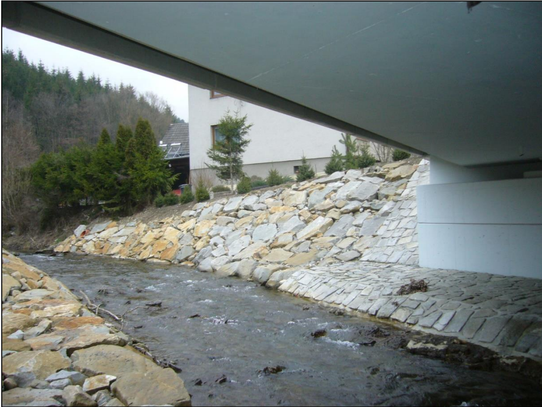
Příloha 13: Zpevnění břehů Dřevnice v Kašavě, vlastní foto
