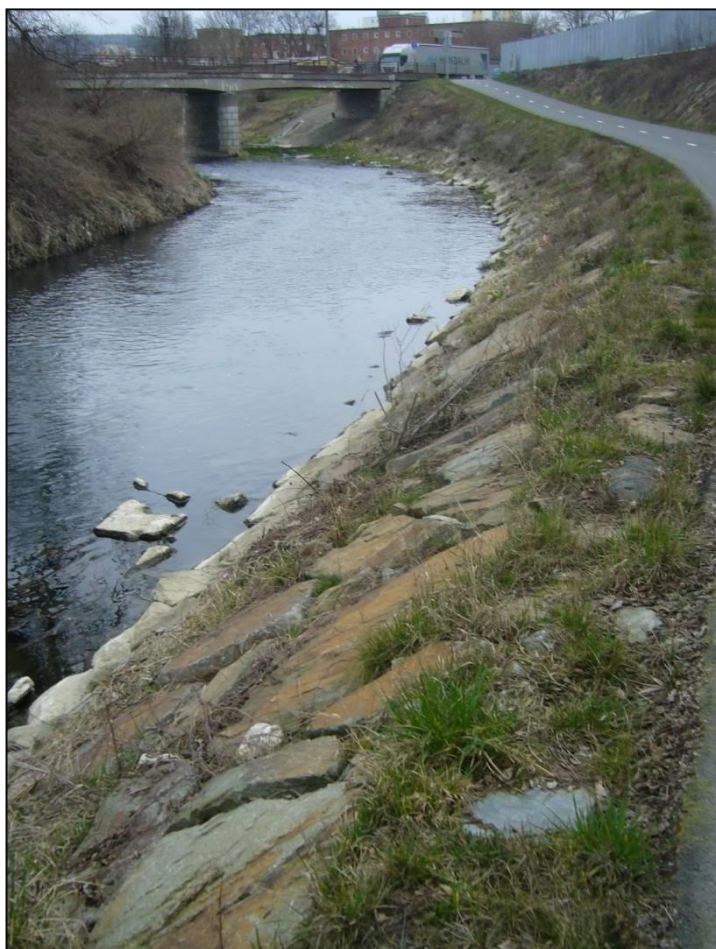
Příloha 1: Zpevnění břehů koryta, vlastní foto
