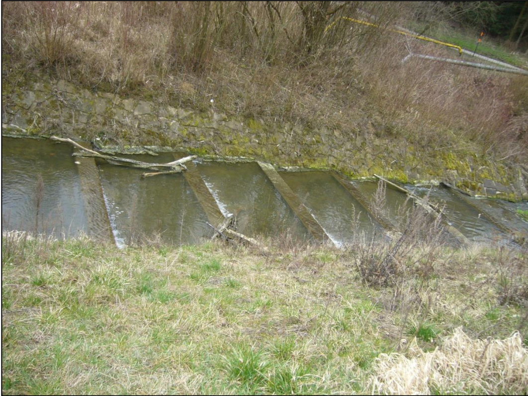
Příloha 5: Výpusť Příluckého rybníka, vlastní foto
