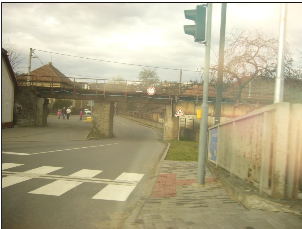
Příloha 7: Železniční nadjezd na trati Otrokovice-Zlín-Vizovice, vlastní foto
